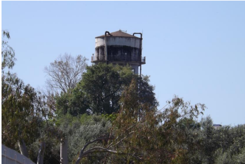
Φώτο Ε.7: Υδραγωγείο πόλης Αμαλιάδας (μακρινή λήψη)
