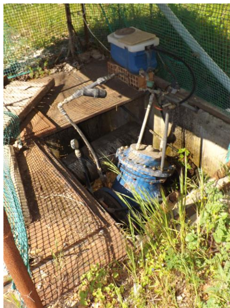
Φώτο Ε.6: Φρεάτιο παραλαβής νερού από τις πηγές Κακοταρίου που βρίσκεται στην περιοχή του υδραγωγείου
