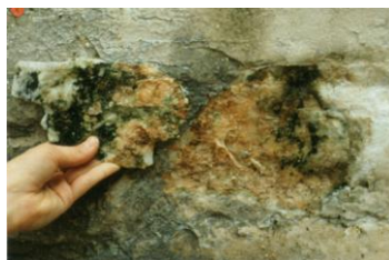
Εικόνα 3: Βιοδιάβρωση σε μαρμάρινη επιφάνεια
