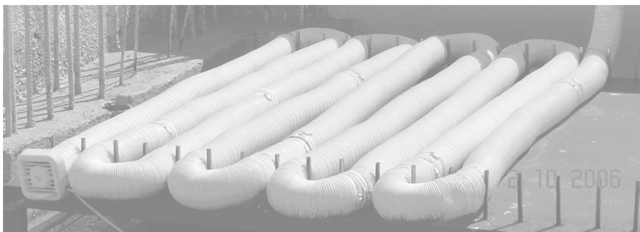
Σχήμα 2.5.1: Η αρχική μορφή του μεταλλικού αγωγού μόλις διπλώθηκε στην ειδικά διαμορφωμένη βάση του.
