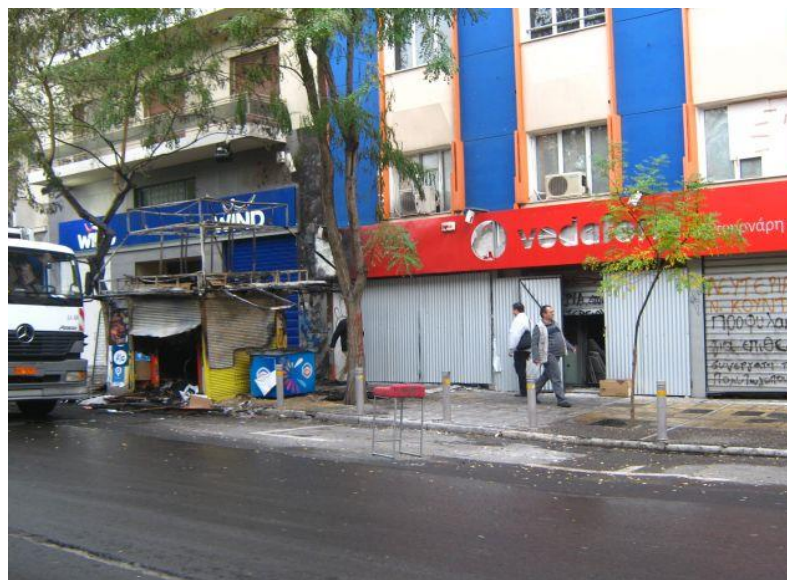
Σπασμένα και καμένα καταστήματα κινητής τηλεφωνίας, πηγή: Εξέγερση οδοιπορικό, https://athens.indymedia.org/
