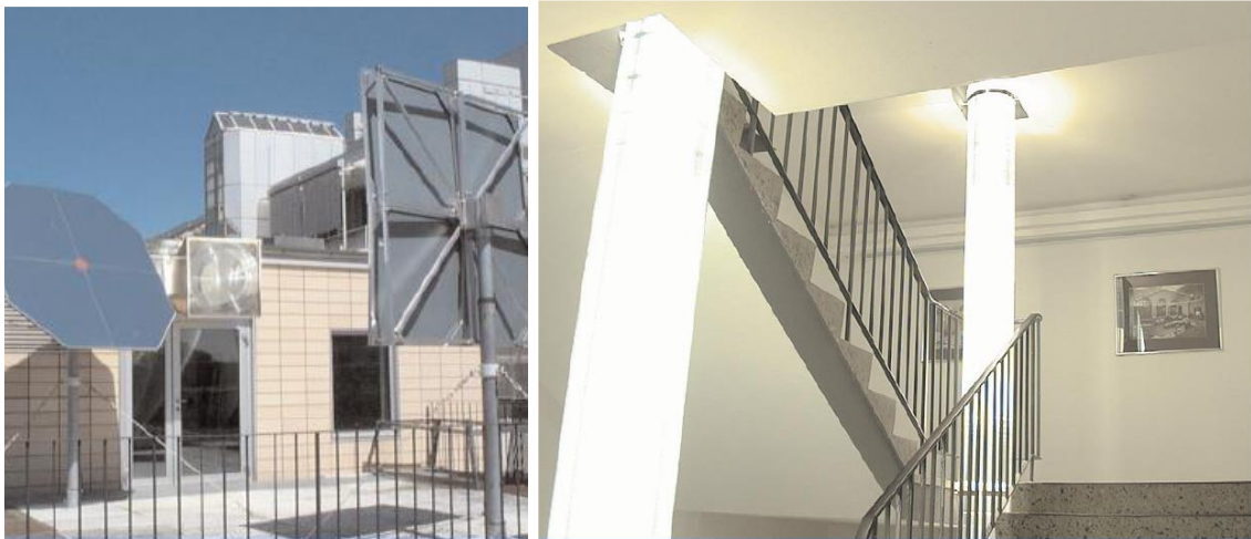
Εικ. 5,6: Υβριδικό σύστημα φωτισμού Arthelio. Στην αριστερή εικόνα, ο ηλιοστάτης.
