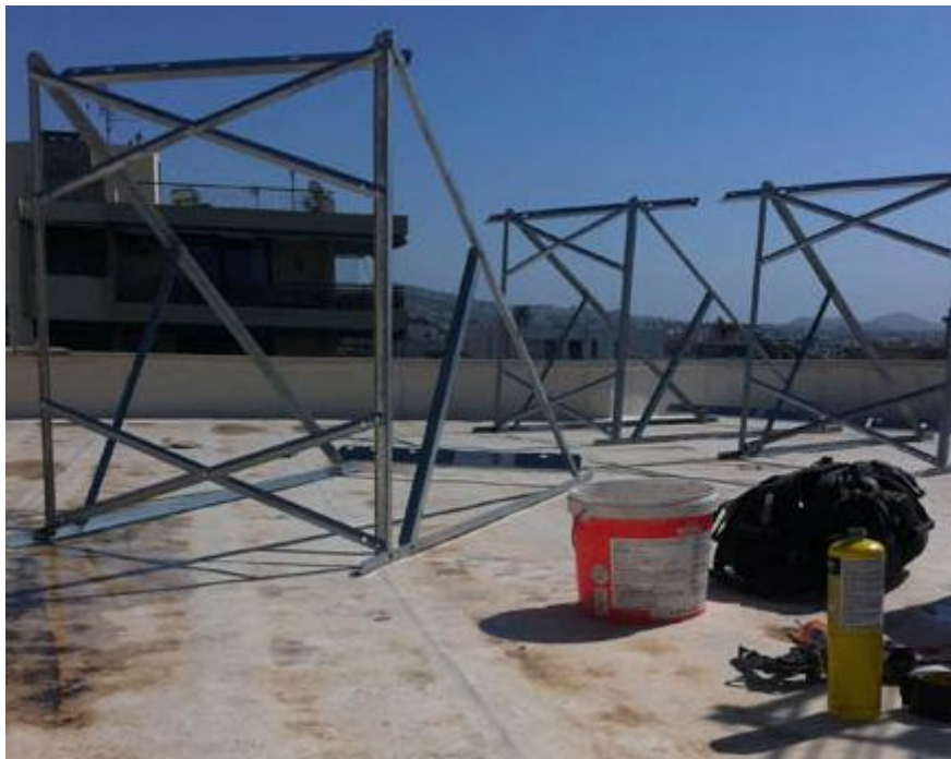
Σχήμα 5.12 : Βάση στήριξης συλλεκτών
