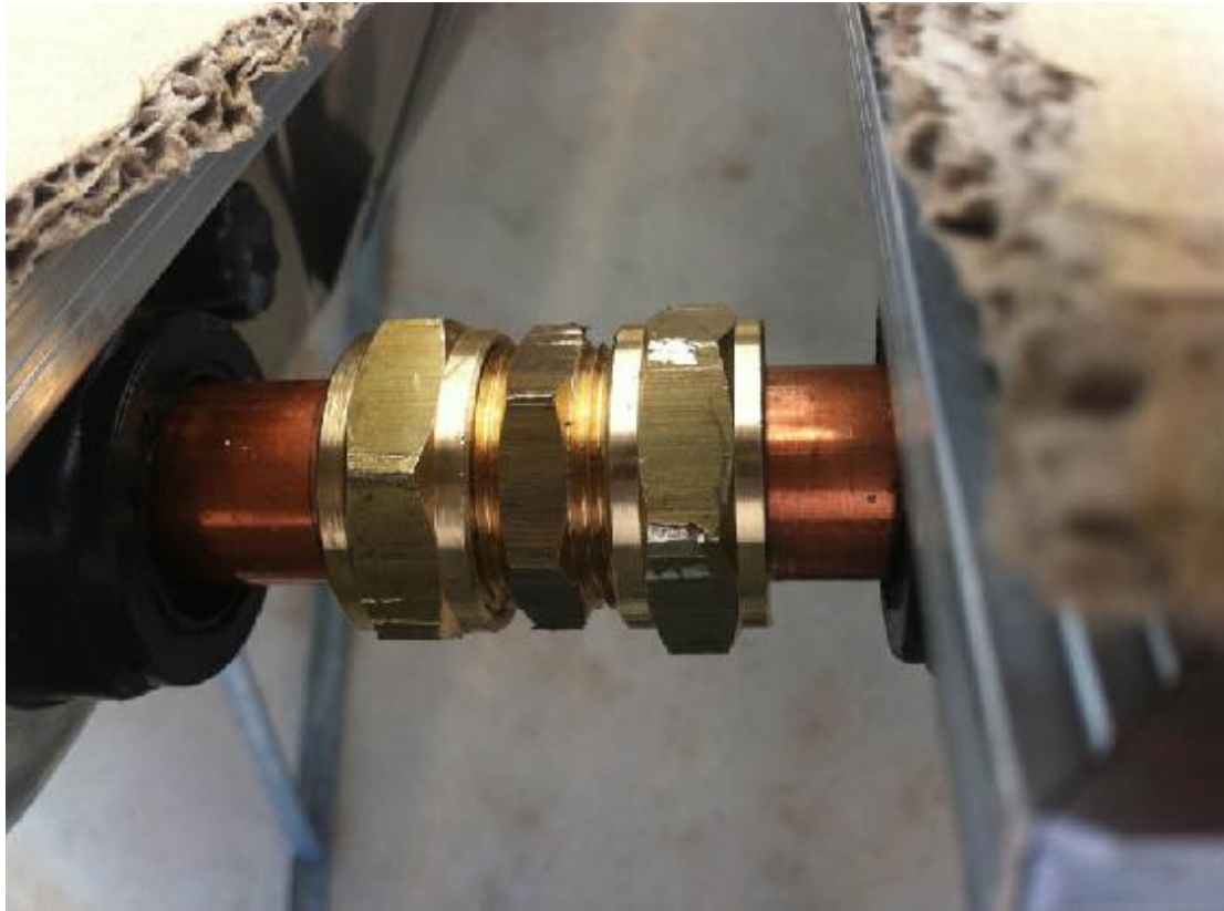
Σχήμα 5.9: Σύνδεση με ρακόρ 2 διαδοχικών συλλεκτών
