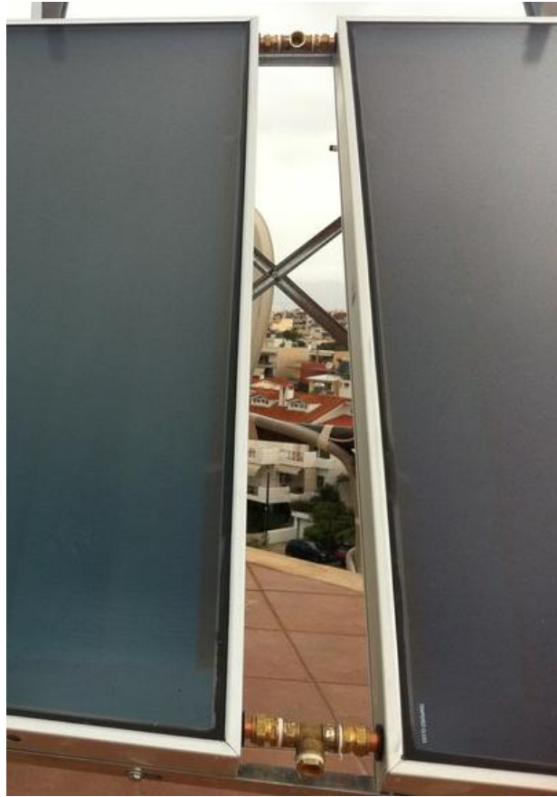
Σχήμα 5.10 :Τελική σύνδεση συλλεκτών
