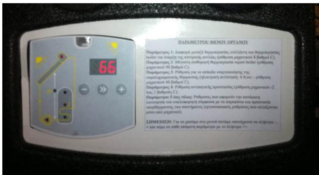
Σχήμα 5.18: Διαφορικός θερμοστάτης εγκατάστασης (ενσωματωμένος στο σετ LOGASOL)
