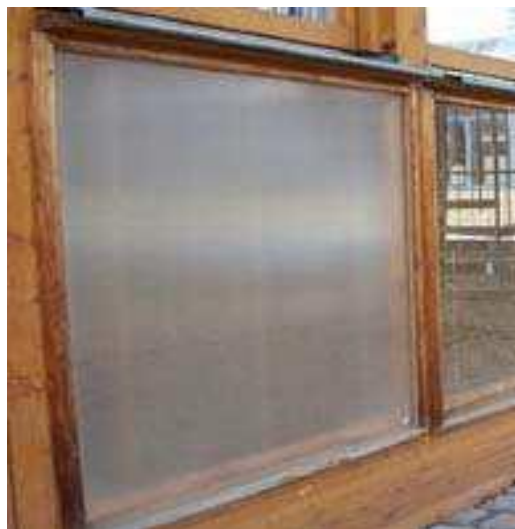
Σχήμα 3.30: Διαφανές μονωτικό υλικό τοποθετημένο σε τοίχο [11]
