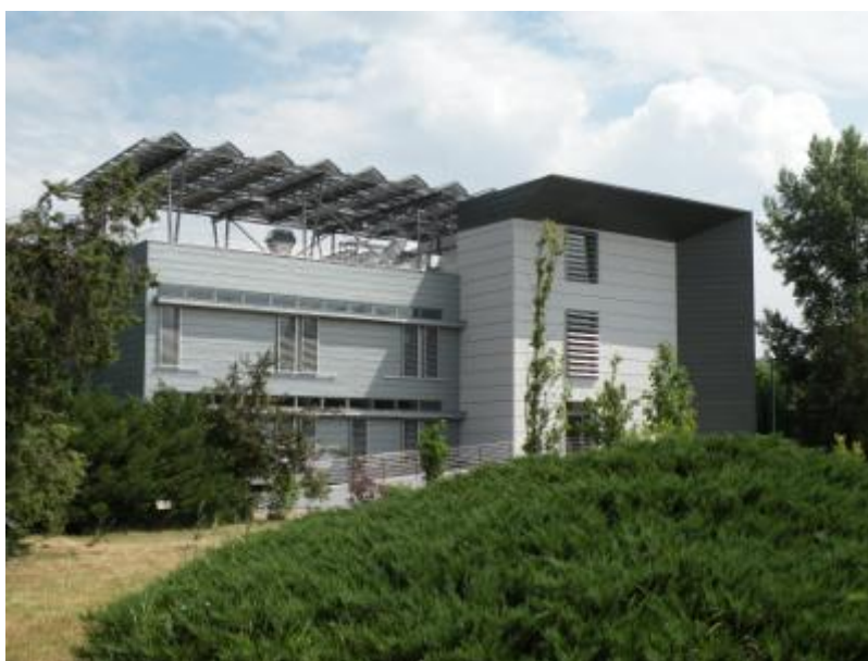
Εικόνα 2.2: Κτίριο Μηδενικής Κατανάλωσης REC , Ουγγαρία
