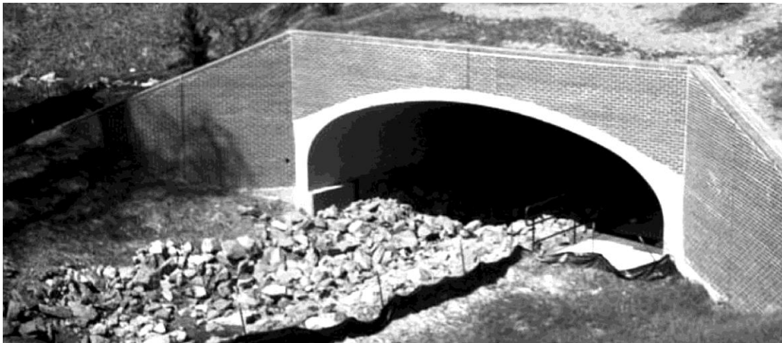
Παράδειγμα εγκιβωτισμού κοίτης ποταμού (πηγή: http://raleigh-consult.limehouse.com )
