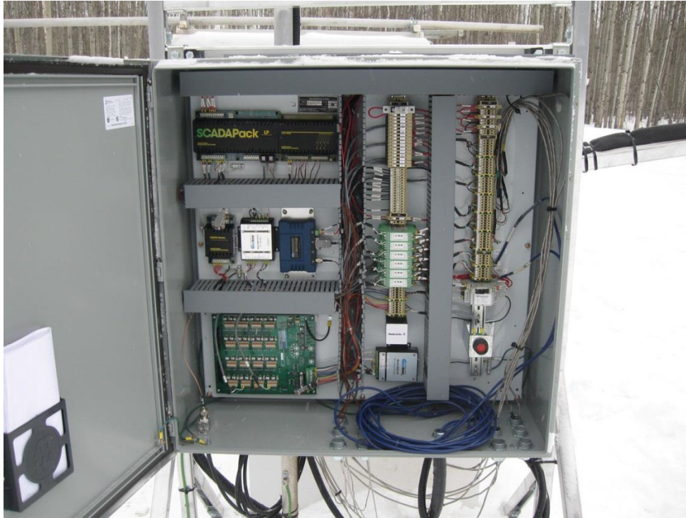
Σχήμα 2.6 Εσωτερική εγκατάσταση RTU
