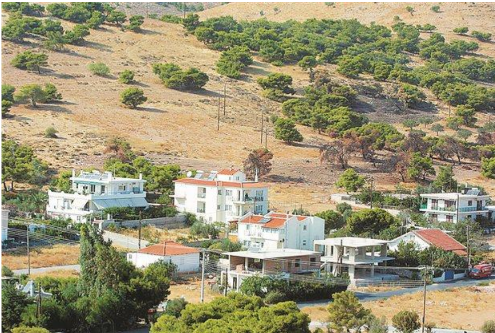
Εικόνα 10.4: Αυθαίρετες κατοικίες στην Αττική (Πηγή: www.tovima.gr )
