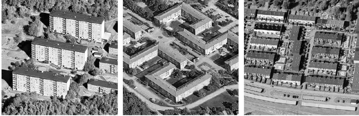
Εικόνα 8.4: Τρία παραδείγματα οικοδομικών προτύπων που κατασκευάστηκαν στα πλαίσια του The Million Homes Programme (Πηγή: Castell P., 2010, σελ. 8)
