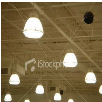
Εικόνα 7.4 Λαμπτήρες metal halide
