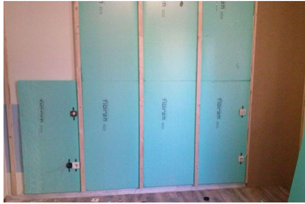
Εικόνα 1.2 Εσωτερική θερμομόνωση δωματίου [28]
