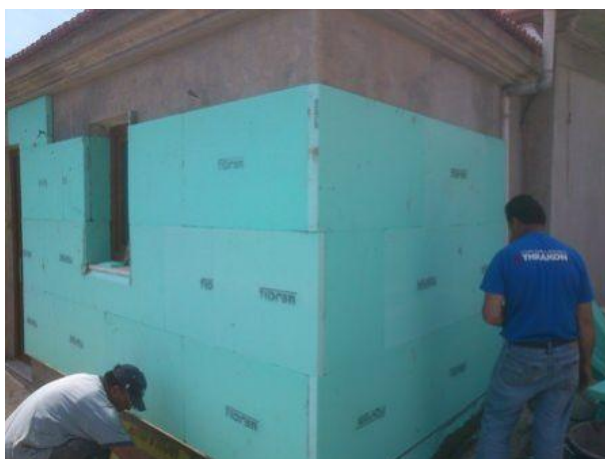
Εικόνα 1.1 Εξωτερική θερμομόνωση κτιρίου [28]
