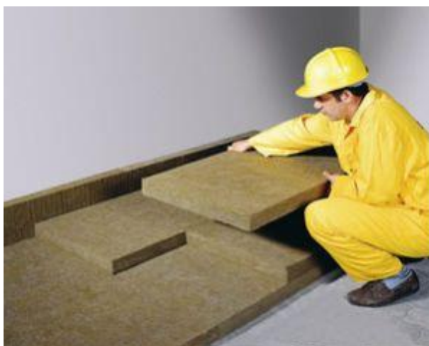
Εικόνα 1.7 Εφαρμογή πλακών πετροβάμβακα σε δάπεδο [33]
