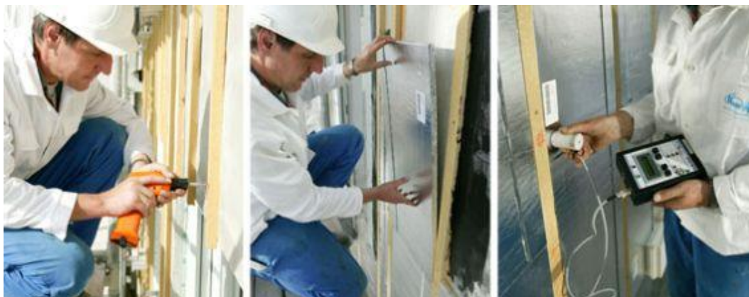
Εικόνα 2-10 Εγκατάσταση πάνελ κενού-VIP σε τοιχοποιία [48]
