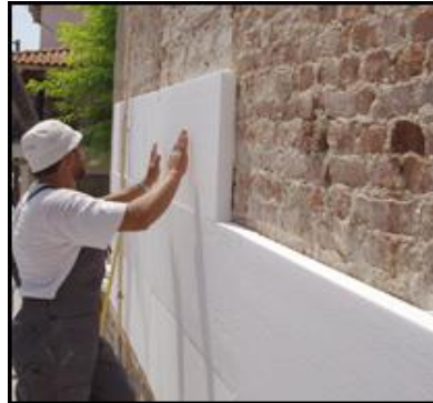
Εικόνα 2-4 Τοποθέτηση διογκωμένης πολυστερίνης σε εξωτερική τοιχοποιία [46]
