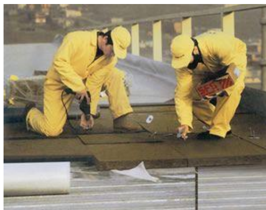
Εικόνα 2-7 Εφαρμογή στρώματος πετροβάμβακα σε οροφή [43]
