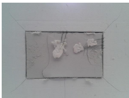
Εικόνα 4-3 Εσωτερική όψη πρώτου δοκιμίου
