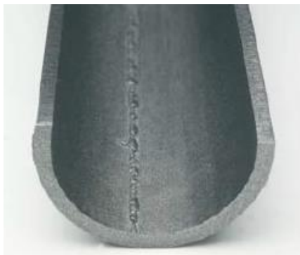
Εικόνα 1-19: Χαλυβδοσωλήνες ψυχρής σωληνοποίηση χωρίς εξομάλυνση και χωρίς αφαίρεση της εσωτερικής κρέμασης της συγκόλλησης.
