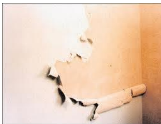
Σχήμα 11: Αποφλοίωση του χρώματος [ http://www.greekarchitects.gr ]
