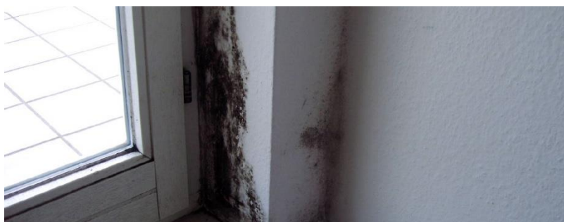
Σχήμα 10: Νηματοειδής διάβρωση σε θερμογέφυρα τοιχοποιίας [ http://econorm.gr/diaf.php?id=2&lang=1 ]
