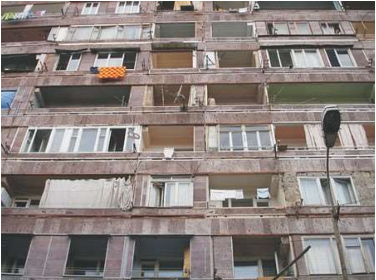
162-164. Πρόσοψη πολυκατοικίας μαζικής στέγασης στο κεντρικό τμήμα της πόλης “κρυμμένη” στην εσωτερική αυλή, πλαισιωμένη απο περιποιημένες προσόψεις κτιρίων. Επάνω αριστερά διακρίνεται το χαρακτηριστικό πέρασμα που οδηγεί στις αυλές.
