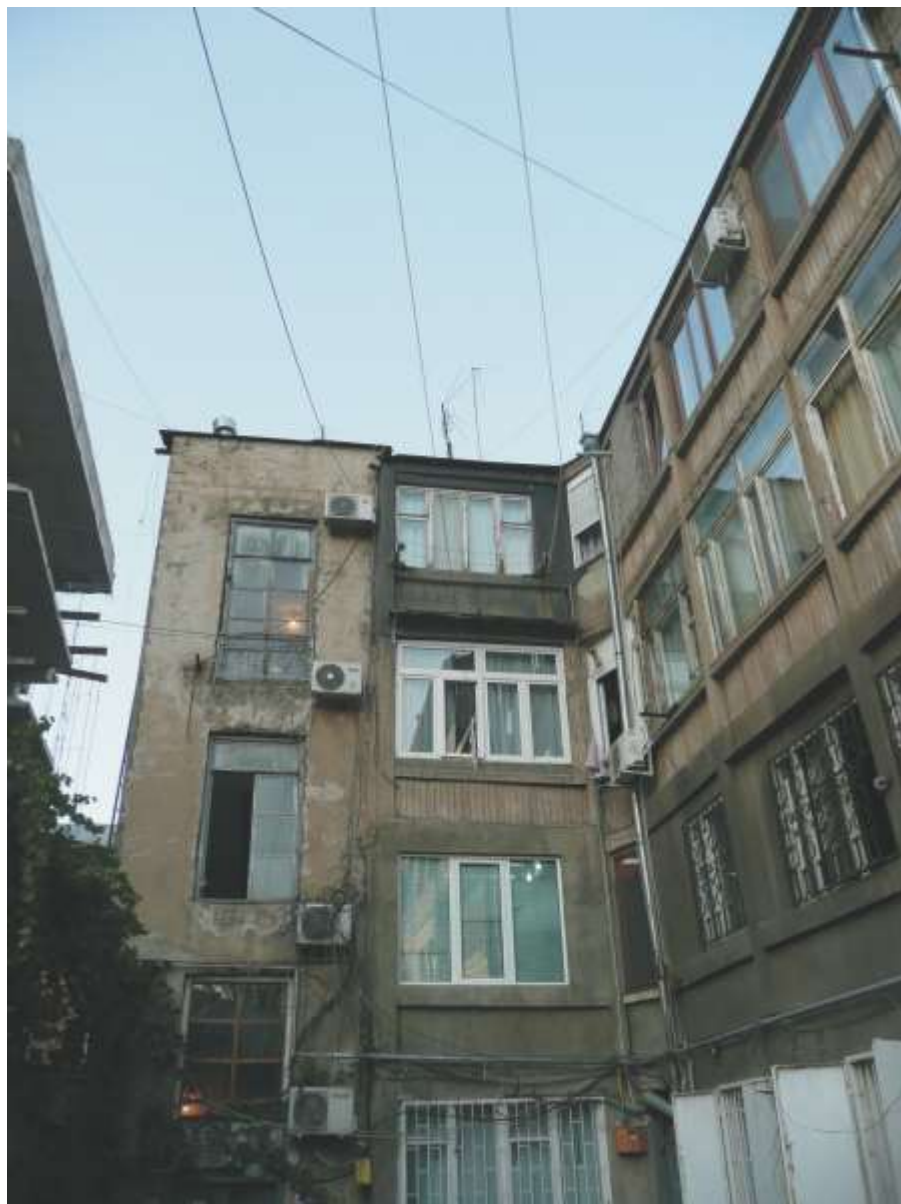
165-167. Προσόψεις πολυκατοικιών μαζικής στέγασης στο κεντρικό τμήμα της πόλης.
