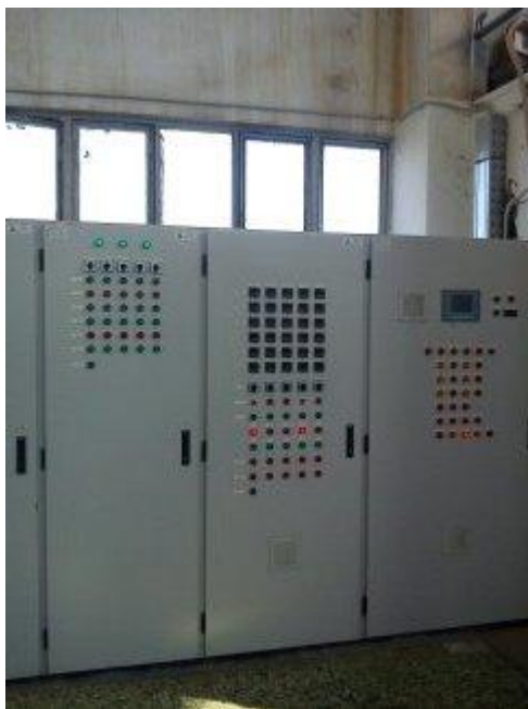
Εικόνα 9.9: Πίνακες (εσωτερικός χώρος στον Ανάβαλο)
