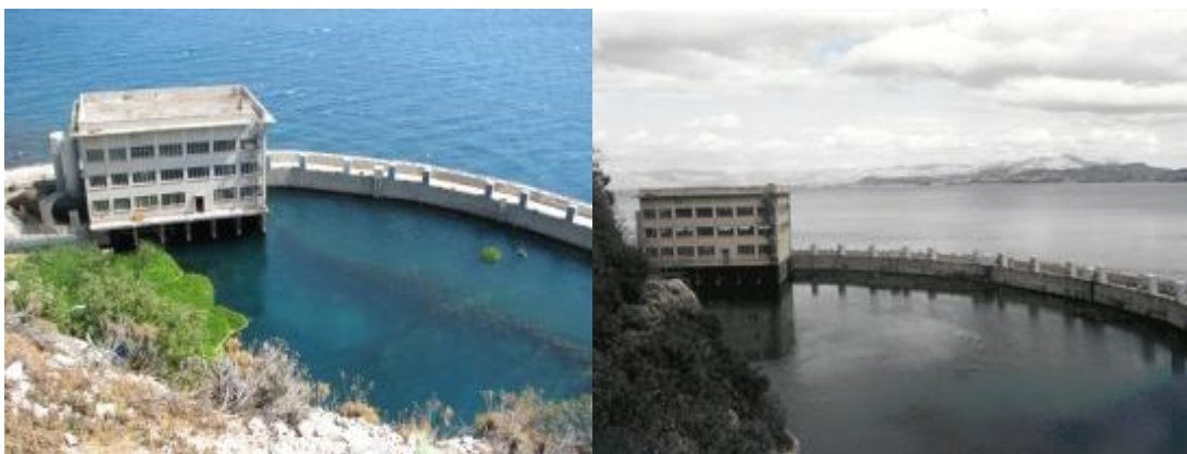
Σχήμα 5.7: Φωτογραφία φράγματος Αναβάλου (Κιβέρι)
