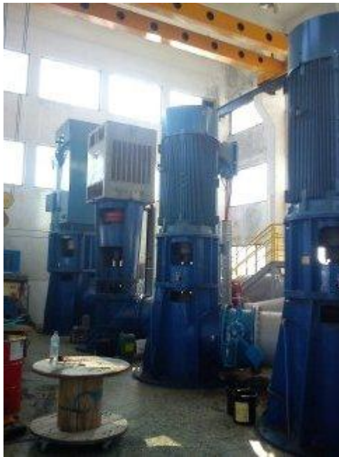
Εικόνα 9.7: Μηχανές αντλιοστασίου (εσωτερικός χώρος στον Ανάβαλο)
