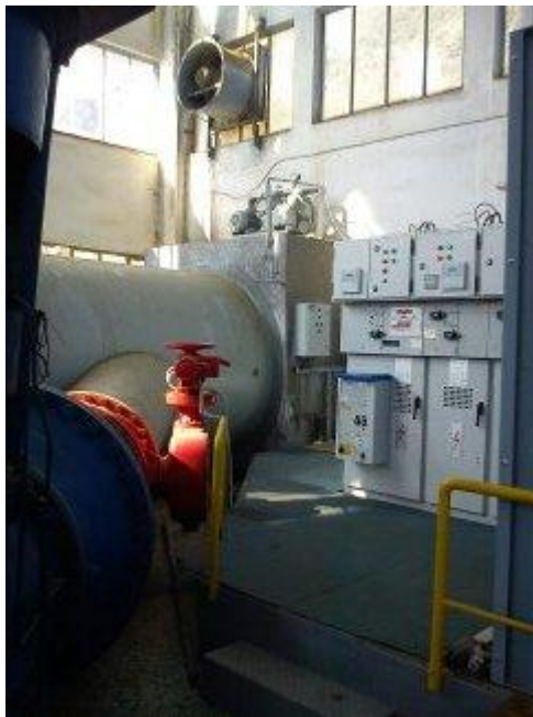
Εικόνα 9.8: Μηχανές αντλιοστασίου (εσωτερικός χώρος στον Ανάβαλο)
