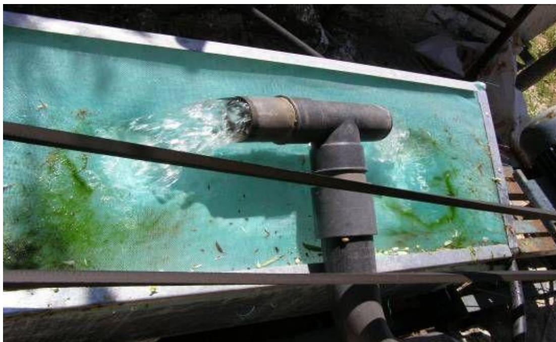
Σχήμα 6.12: Καθαρισμός νερού με σήτα κατακράτησης φερτών
