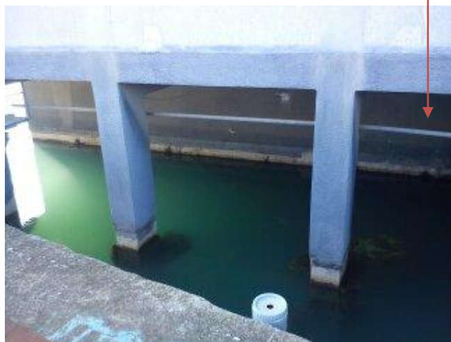
Εικόνα 9.5: Φράγμα Αναβάλου (βλέπουμε ότι από κάτω είναι κούφιο)
