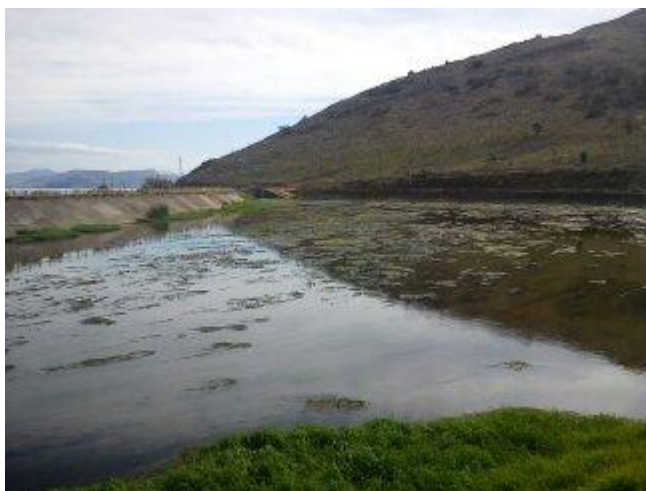
Εικόνα 8.3: Διώρυγα Αναβάλου (Χώρος συγκέντρωσης των νερών που έρχονται από τον Ανάβαλο μέσω αντλιοστασίου – από αυτό το σημείο και μετά μέχρι το κεφαλάρι τα νερά κινούνται με την βαρύτητα)
