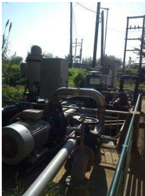
Σχήμα 5.14: Αντλιοστάσιο Λέρνης (πηγή ύδρευσης πόλης Άργους και Ναυπλίου)
