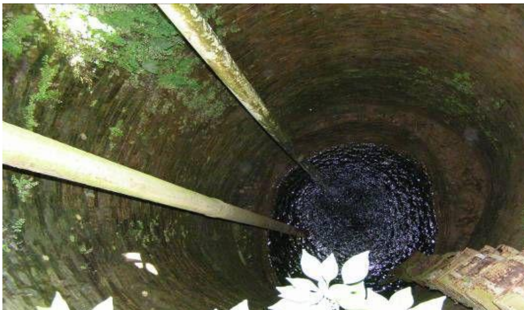
Σχήμα 6.13: Εμπλουτισμός σε φρέαρ μέσω ειδικής σωλήνωσης
