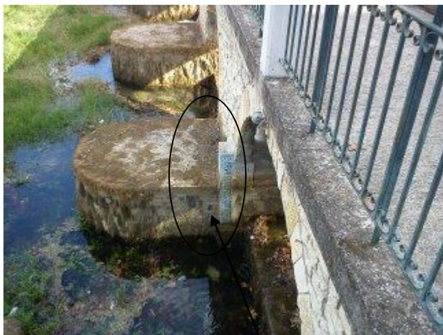
Εικόνα 11.3: Κατασκευασμένο πιεζόμετρο (Πηγή Κεφαλαρίου)
