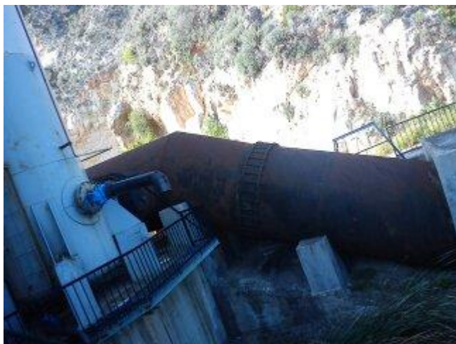
Εικόνα 9.10: Αγωγός μεταφοράς νερού από τον Ανάβαλο
