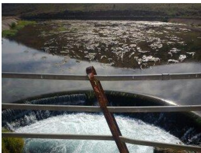
Εικόνα 8.4: Διώρυγα Αναβάλου (Χώρος συγκέντρωσης των νερών που έρχονται από τον Ανάβαλο μέσω αντλιοστασίου – από αυτό το σημείο και μετά μέχρι το κεφαλάρι τα νερά κινούνται με την βαρύτητα)
