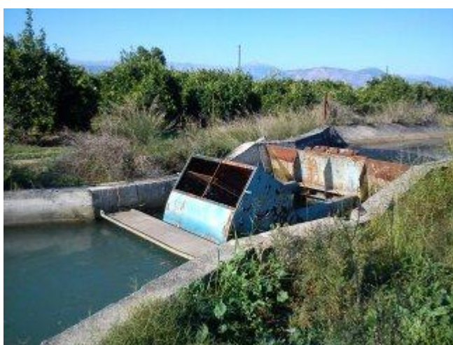
Εικόνα 5.4: Σύστημα ΑΒΥΣ στο αρδευτικό δίκτυο (ανοιχτό) (εκεί όπου έχουμε στένωση του δικτύου ώστε να επιτυγχάνεται μεγαλύτερη ταχύτητα του νερού)
