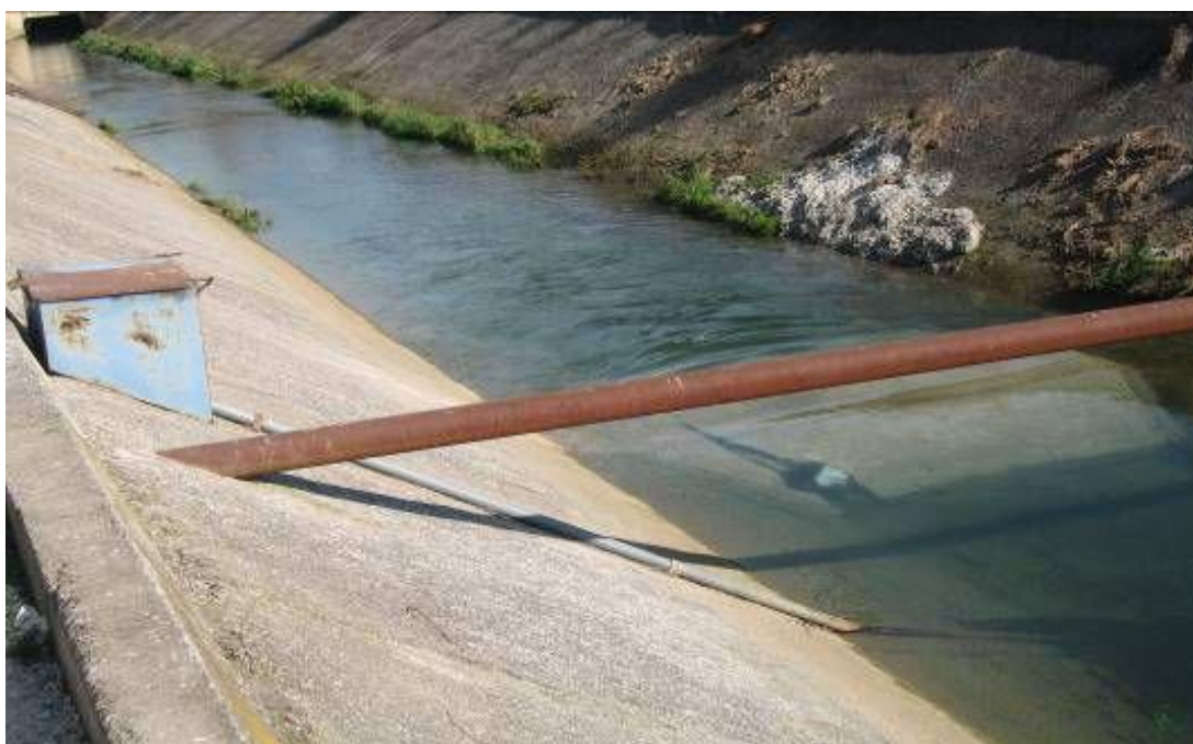
Σχήμα 6.15:. Σταθμηγράφος συνεχούς καταγραφής και εκχειλιστής στην διώρυγα Αναβάλου
