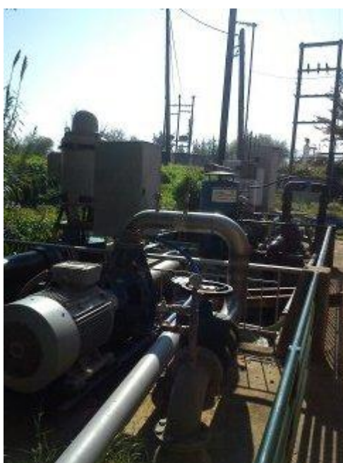
Εικόνα 10.2: Αντλιοστάσιο Λέρνης (πηγή ύδρευσης πόλης Άργους και Ναυπλίου)
