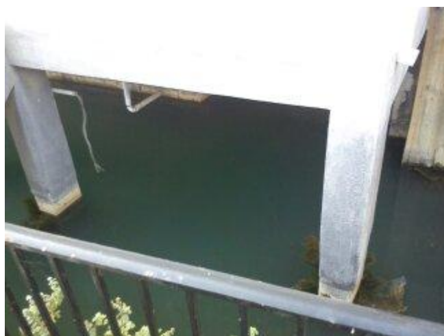
Εικόνα 9.6: Φράγμα Αναβάλου (βλέπουμε ότι από κάτω είναι κούφιο)
