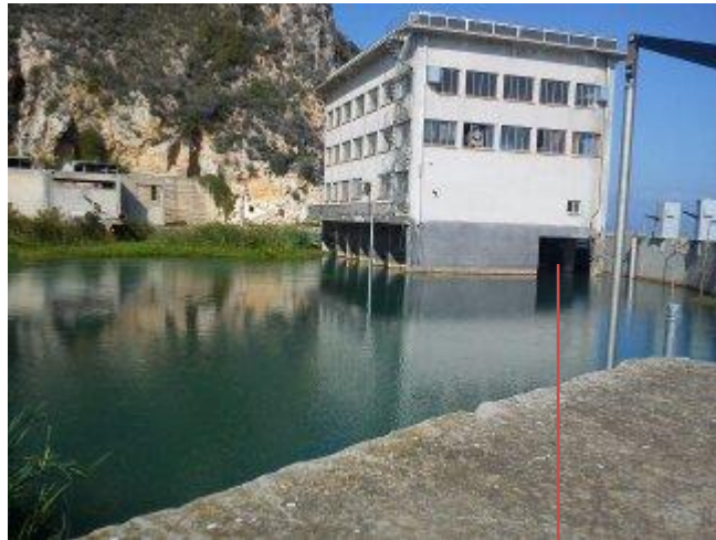
Εικόνα 9.4: Φράγμα Αναβάλου (αντίθετη λήψη)
