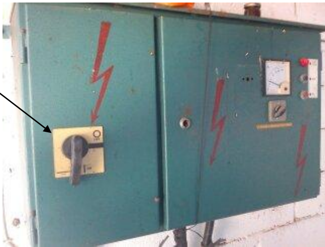
Εικόνα 4.2: Κουτί γεώτρησης (παροχή ρεύματος)
