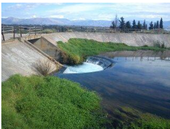
Εικόνα 8.2: Διώρυγα Αναβάλου (Χώρος συγκέντρωσης των νερών που έρχονται από τον Ανάβαλο μέσω αντλιοστασίου – από αυτό το σημείο και μετά μέχρι το κεφαλάρι τα νερά κινούνται με την βαρύτητα)
