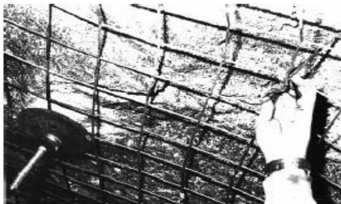
Εικόνα 4.9 Δομικό χαλύβδινο συγκολλημένο πλέγμα ενίσχυσης (Hoek et al.,1993)
