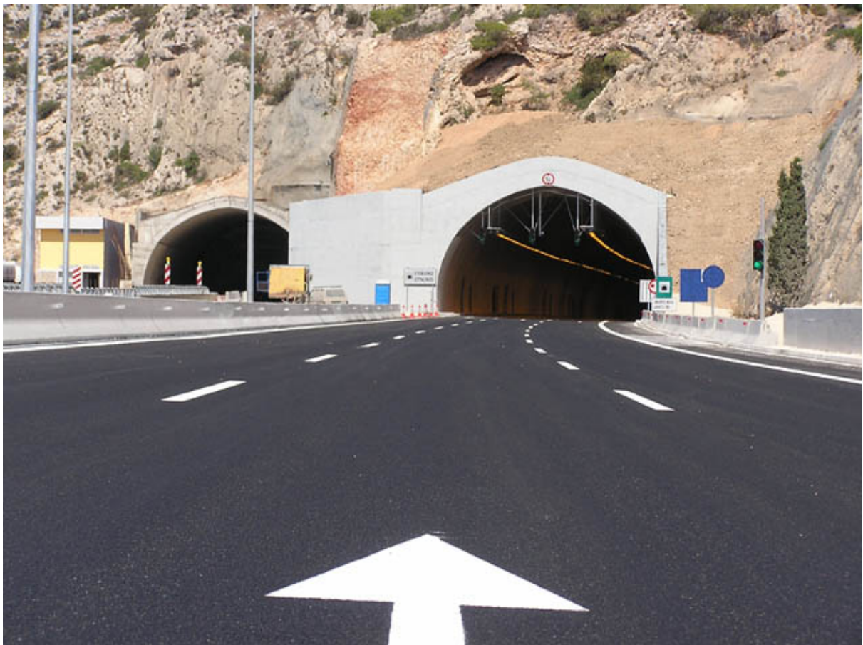
Σχήμα 7.1.6. Σήραγγες Κακιάς Σκάλας
