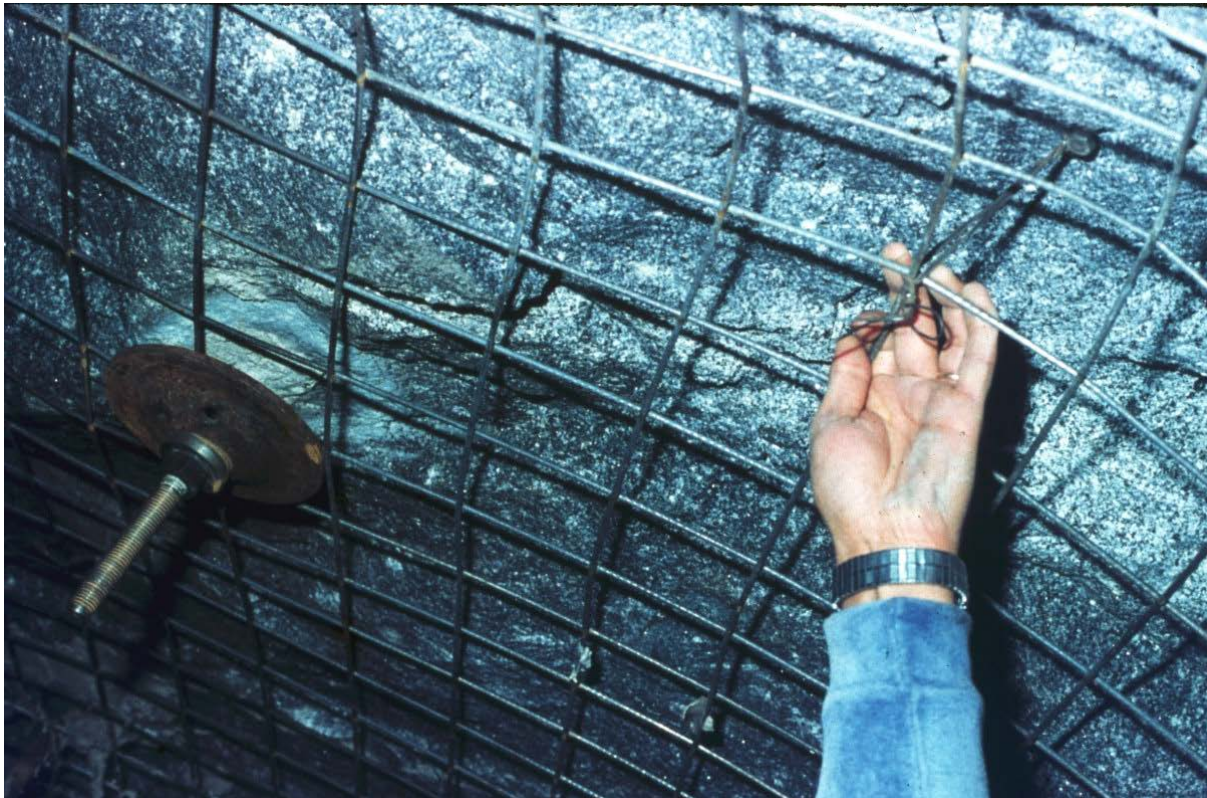
Σχήμα 5.4.1. Συγκολλημένο πλέγμα, σφιχτά εφαρμοσμένο στην επιφάνεια του βράχου, προσφέρει άριστη όπλιση για το εκτοξευόμενο σκυρόδεμα
