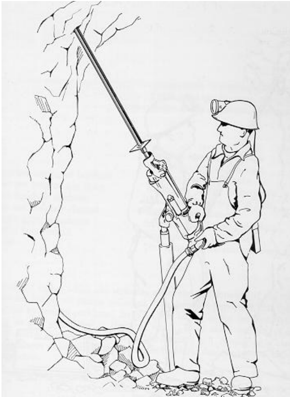
Σχήμα 6.1.12. Τοποθέτηση ήλου Split Set®
