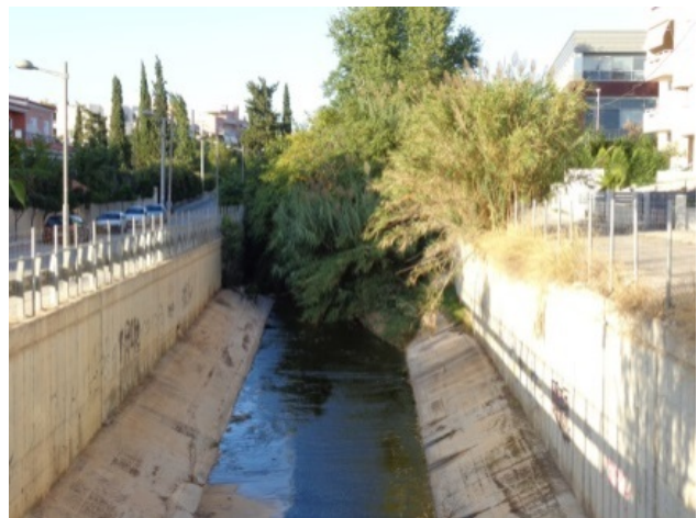
Εικόνα 74 _ Διευθέτηση με ανοικτό αγωγό Προσωπική Λήψη
