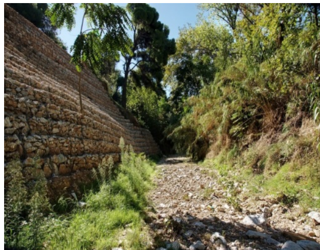
Εικόνα 84 _ Διευθέτηση με φυσικά υλικά http://www.panoramio.com/photo/27733761
