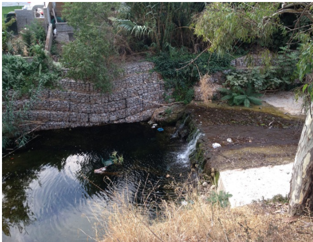
Εικόνα 83_ Διευθέτηση με φυσικά υλικά http://eliasdimitriou.com/2013/10/09/ρέμα-χαλανδρίου-ένας-αστικός-υγρότοπ/
