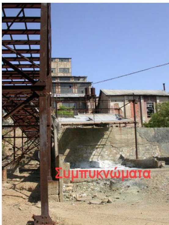
Εικόνα 3.11 Σωροί μεταλλευτικών συμπυκνωμάτων σε πρώην στεγασμένο χώρο αποθήκευσης αυτών (Λιακόπουλος, 2009)
