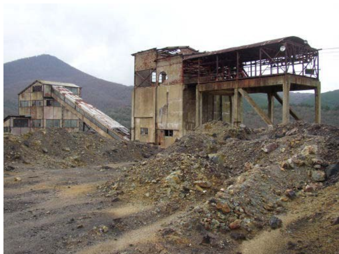
Εικόνα 3.12 Σωροί απορριμμάτων εμπλουτισμού (Λιακόπουλος, 2009)
