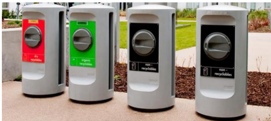
Εικόνα 3: Παράδειγμα εγκατάστασης κάδων συλλογής αστικών λυμάτων με σύστημα AVAC (Πηγή: Διαδίκτυο)
