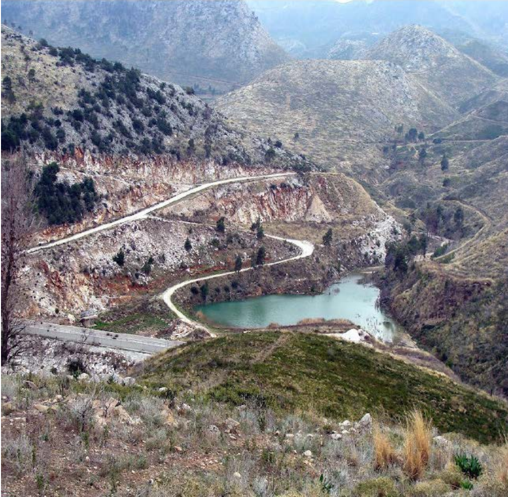
Σχήμα 3.4: Φράγμα Ραπεντώσας και τεχνητή λίμνη φράγματος. (Τα φράγματα της Ελλάδας, 2013).
