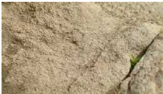
Εικ.4: Κρούστα ανακρυστάλλωσης - Ζαχαρωειδής φθορά
