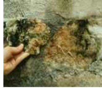
Εικ. 12: Αποτέλεσμα βιολογικής φθοράς
