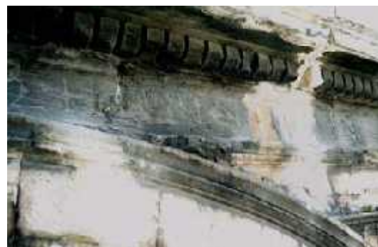
Εικ.20: Απόπλυση από τρεχούμενο νερό όξινης βροχής
