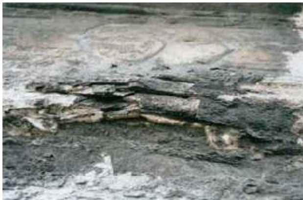
Εικ. 17,18: Περικρυσταλλική αποσάθρωση, πλέγμα μικρορωγμών και απολεπίσεις
