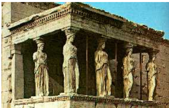
Εικ.6: Η διάλυση του στρώματος του γύψου στην επιφάνεια του πεντελικού μάρμαρου απαλείφει τις λεπτομέρειες από το πρόσωπο και τις πτυχές του χιτώνα των Καρυατίδων.
