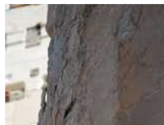
Εικ. 17,18: Περικρυσταλλική αποσάθρωση, πλέγμα μικρορωγμών και απολεπίσεις
