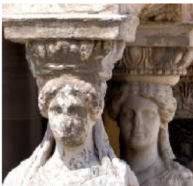
Εικ. 11: Ασβεστοποίηση μαρμάρου
