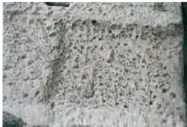
Εικ. 13: Κυψελοειδής φθορά από μη ενεργή, πλέον, βιοδιάβρωση
