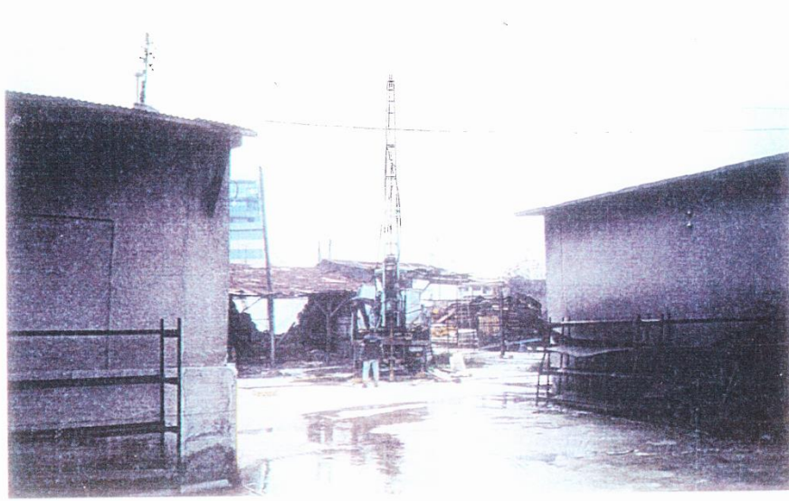
Φωτογραφία 1: Γεωτρύπανο στη θέση Γ1
