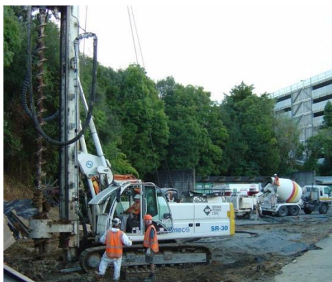
Εικόνα 19: Διατρητικό μηχάνημα πασσάλων
