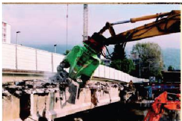
Εικόνα 35: Κατεδάφιση με χρήση υδραυλικής σιαγώνας βαρέως τύπου. ΠΗΓΗ: Ελληνική Τεχνική Προδιαγραφή, Κατεδαφίσεις
