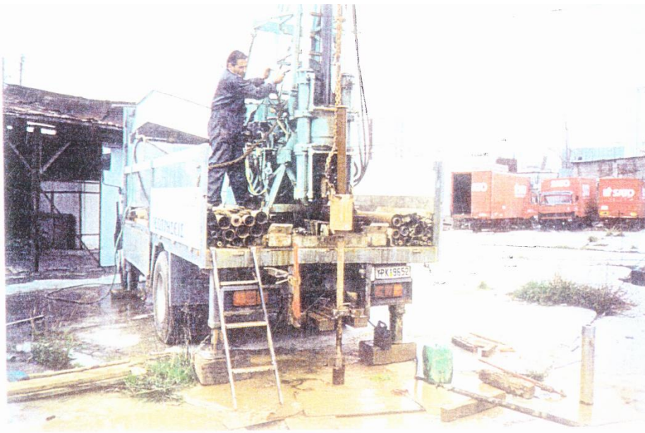
Φωτογραφία 5: Εκτέλεση πρότυπης δοκιμής διείσδυσης(SPT)
