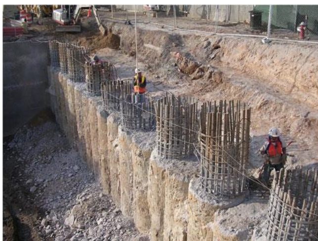
Εικόνα 22: Απεικόνιση πασσαλοστοιχίας ΠΗΓΗ: www.bauerfoundations.com
