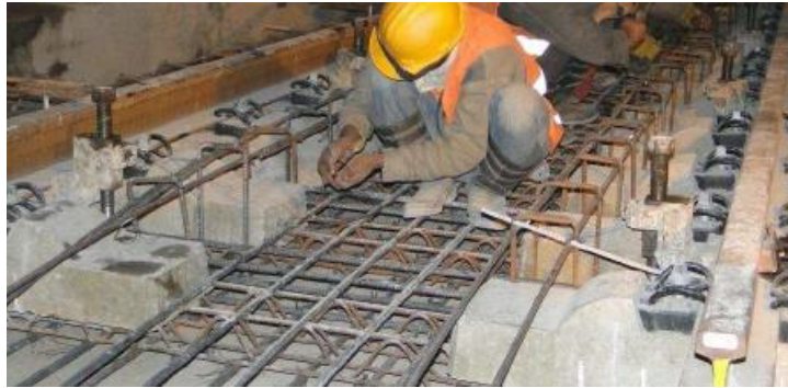
Εικόνα 32: Τοποθέτηση οπλισμού από κάτω προς τα πάνω. ΠΗΓΗ: www.academia.edu
