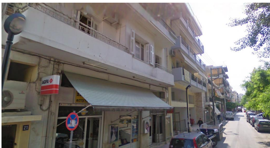
Εικόνα 12: Οικιστική ανάπτυξη νότια της Οδού Πειραιώς, Οδός Θράκης
