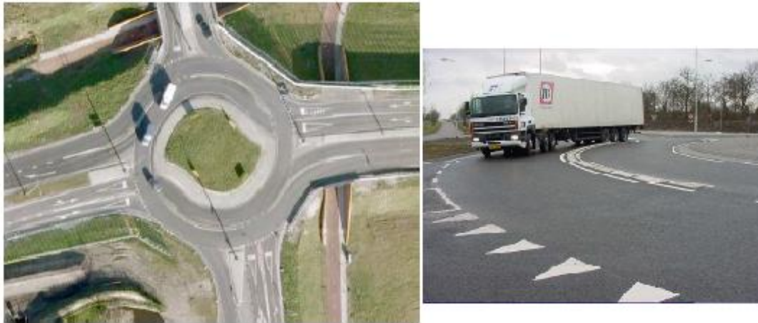
Εικόνα 3.21 Τετρασκελής σπειροειδής κυκλικός κόμβος και βατά υπερυψωμένα διαχωριστικά νησίδων (Fortuijn, 2011)
