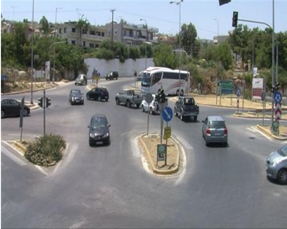
Εικόνα 5.4 Όψη του ισόπεδου τμήματος του κόμβου Ατσιπόπουλου ( http://rethemnosnews.gr )
