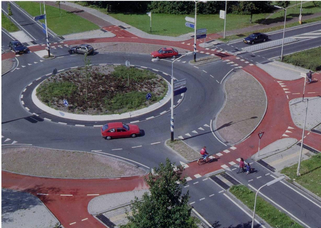
Εικόνα 3.4 Αστικός κυκλικός κόμβος μίας λωρίδας (διαθέτει κατάλληλα διαμορφωμένη περιμετρική ζώνη για φορτηγά) ( http://www.roundaboutsusa.com ).
