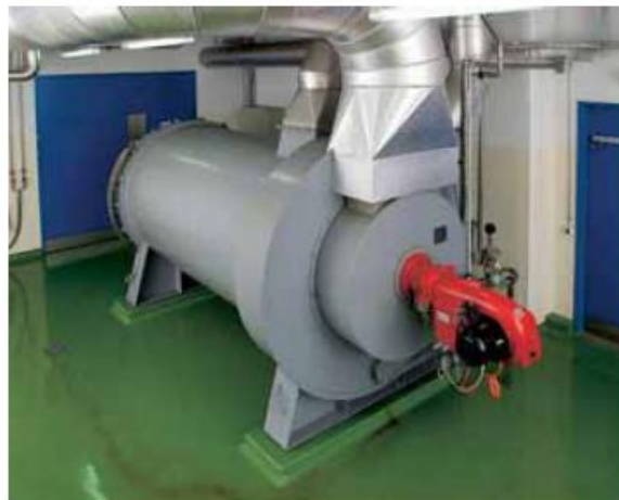
Εικόνα 1.6 Θερμαντήρας αέρα με καύση πετρελαίου
