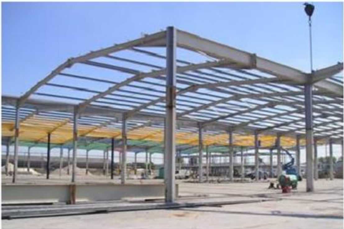
Σχήμα 1.6: Στέγαστρο από στοιχεία ψυχρής έλασης
