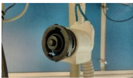
Εικόνα 22 Μαγνητικές βαλβίδες
