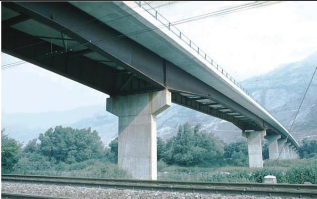
Σχήμα 3.5: Τυπικό παράδειγμα σύμμικτης γέφυρας δύο κύριων δοκών
