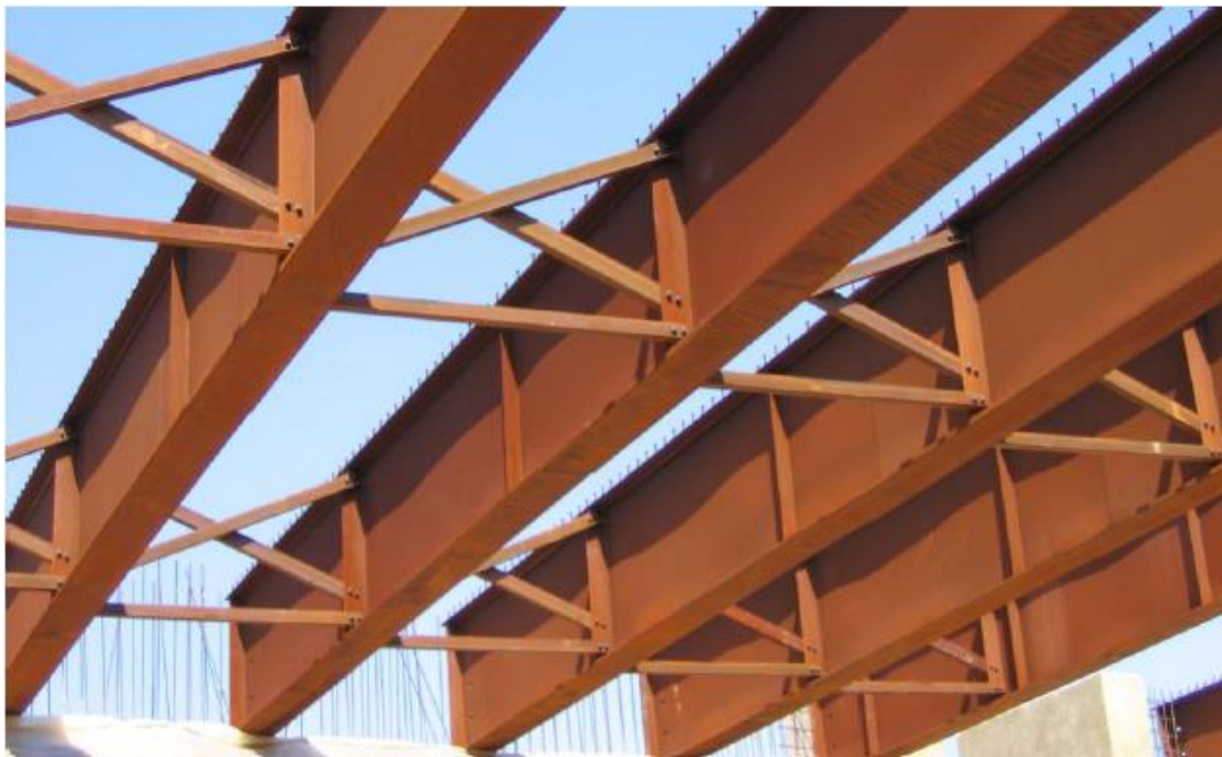
Εικόνα 3.3: Εγκάρσιοι χιαστί σύνδεσμοι μεταξύ των σιδηροδοκών στη φάση κατασκευής
