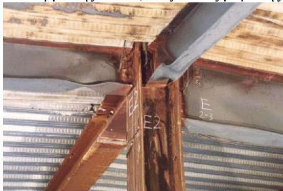
Σχήμα 1.14 Τοπικός λυγισμός στα θλιβόμενα πέλματα δοκού
