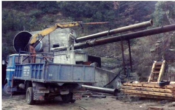
Σχήμα 1-3: Υπέργειος μεταλλικός αγωγός
