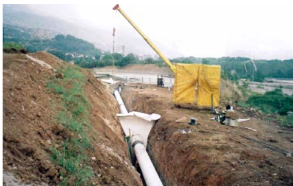
Σχήμα 1-1: Υπόγειος μεταλλικός αγωγός
