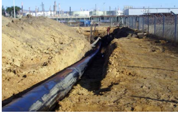
Σχήμα 1-2: Υπόγειος μεταλλικός αγωγός
