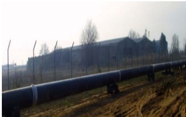
Σχήμα 1-4: Υπέργειος μεταλλικός αγωγός
