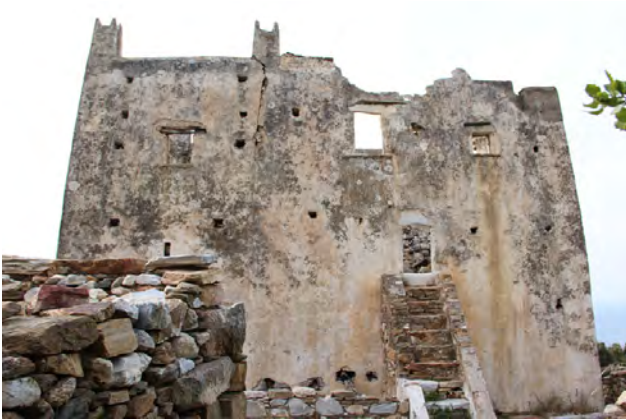
Εικ.70 Νοτιοανατολική όψη πύργου
