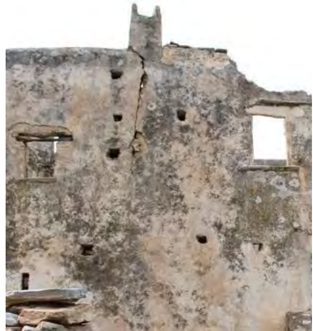
Εικ. 119 Εξωτερική νοτιοανατολική όψη Πύργου
