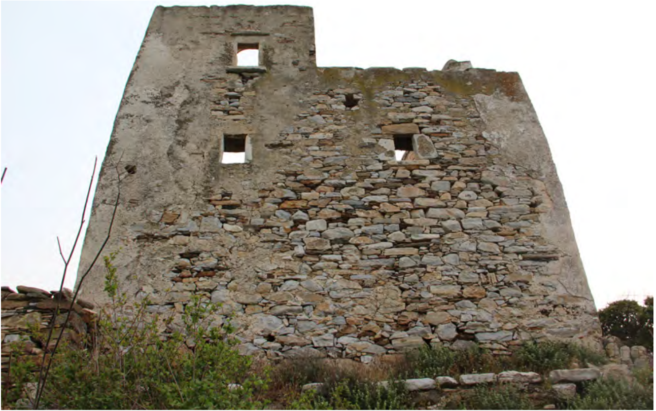
Εικ.75 Βορειοανατολική όψη πύργου.
