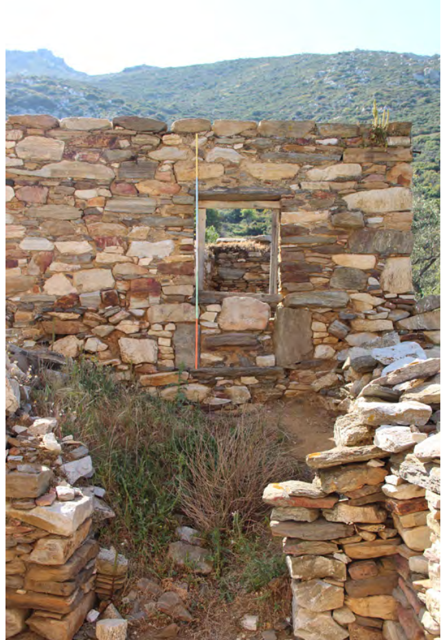
Εικ.89 Βορειοδυτική όψη ελαιοτριβείου. Δεξιά γωνία Διακρίνεται το θωράκιο στο άνοιγμα
