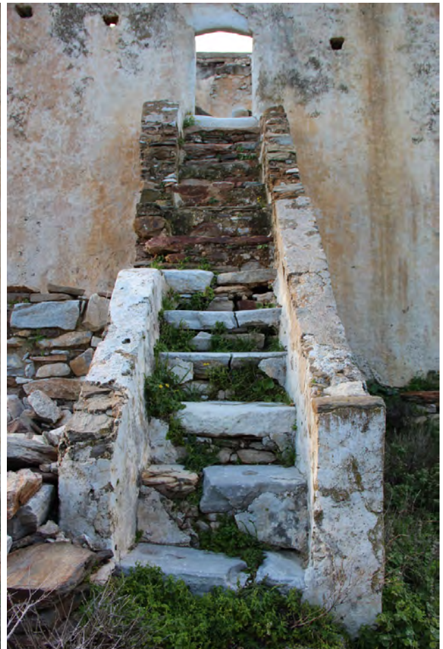
Εικ.100 Ο Πύργος της Αγιάς. Η εξωτερική σκάλα του πύργου που φαίνεται να οικοδομήθηκε σε δύο φάσεις
