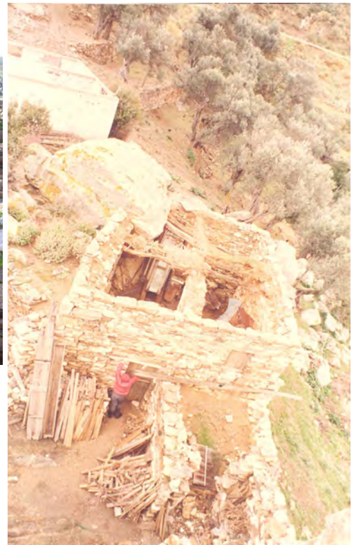
Εικ.64 Φέρων οργανισμός δώματος ελαιοτριβείου, υφιστάμενη κατάσταση
