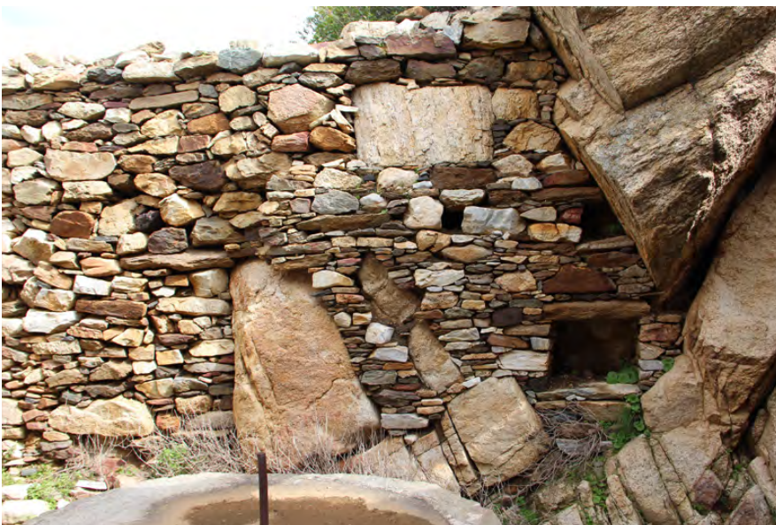
Εικ.95 Εσωτερική παρειά βορειοανατολικής τοιχοποιίας ελαιοτριβείου. Διακρίνεται ο βράχος που αποτελεί μέρος της τοιχοποιίας
