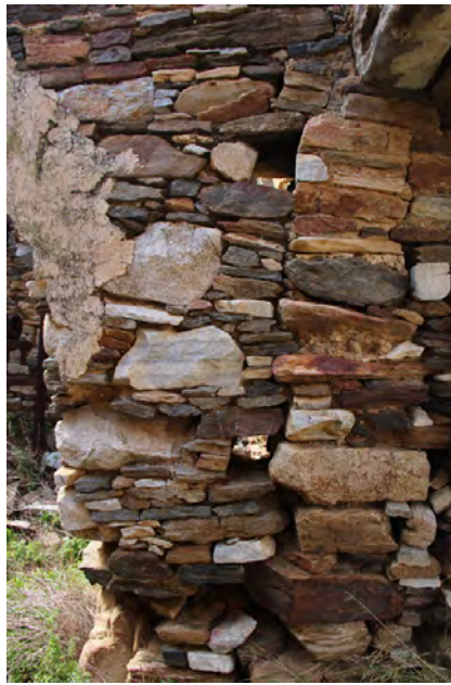
Εικ.91 Ασύνδετο τόξο με την περιμετρική τοιχοποιία
