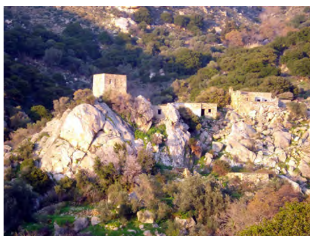
εικ.18 Ο Πύργος έχει χτιστεί σε απότομη, καίριας σημασίας θέση, ώστε να γίνονται αντιληπτοί πιθανοί επιδρομείς. πηγή: google images
