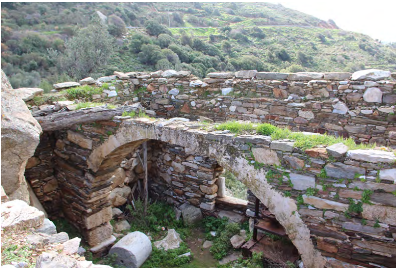
Εικ.64 Φέρων οργανισμός δώματος ελαιοτριβείου, υφιστάμενη κατάσταση
