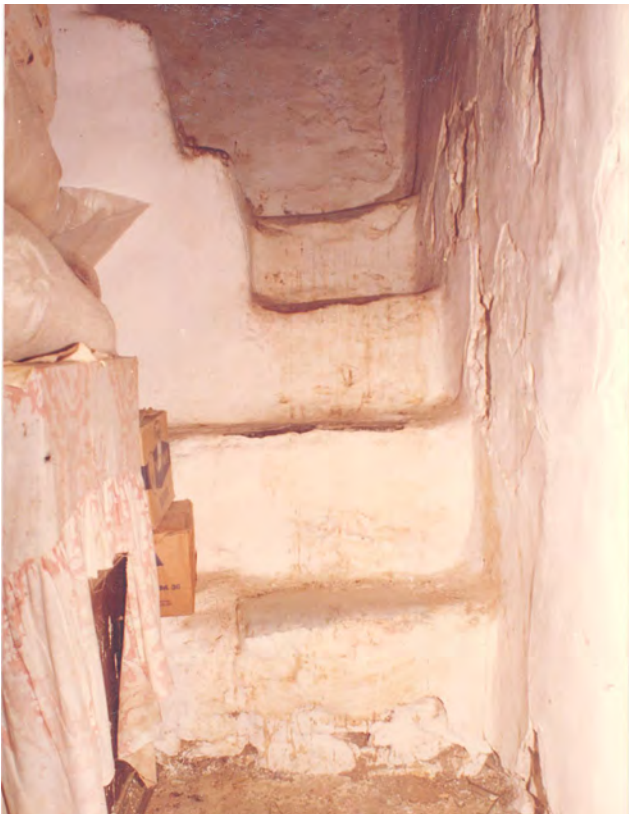
Εικ.55 Ο Πύργος της Αγιάς. Η κλίμακα που συνδέει το επίπεδο Ε2 με το Ε3 στο κομμάτι της Β' οικοδομικής φάσης πηγή: αρχείο Στέλλας Δεμενοπούλου
