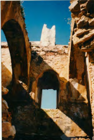
τόξα στο εσωτερικό της Ν.Α. όψης
