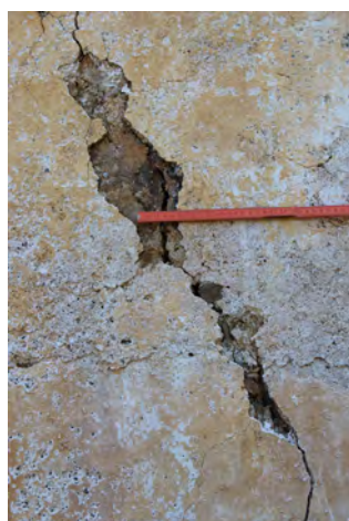
Εικ.83 & 84 Εύρος κατακόρυφης ρωγμής νοτιοδυτικής όψης πύργου
