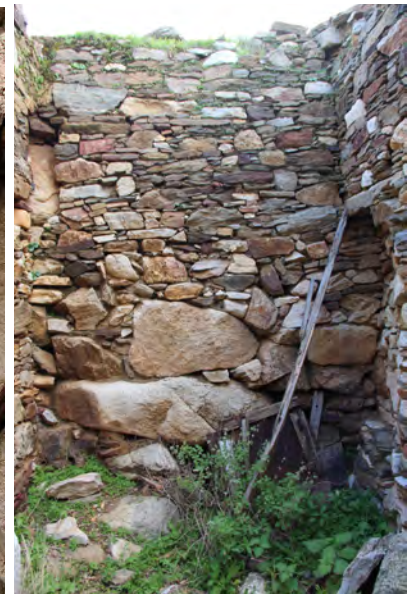
Εικ.96 Εσωτερική παρειά νοτιοανατολικής τοιχοποιίας ελαιοτριβείου.
