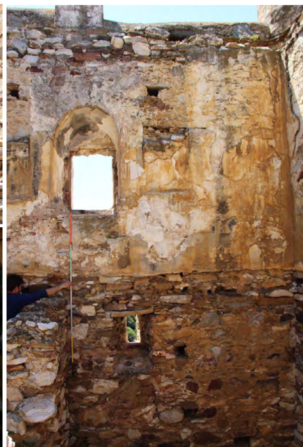
Εικ.87 Εσωτερική παρειά νοτιοδυτικού τοίχου με ίχνη νεώτερου αρμολογήματος
