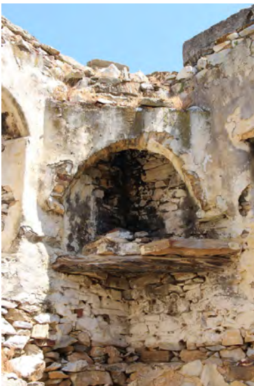
εικ.49 Πύργος Αγιάς. Εστία - τζάκι στο χώρο του μαγειρείου στο τελευταίο επίπεδο.
