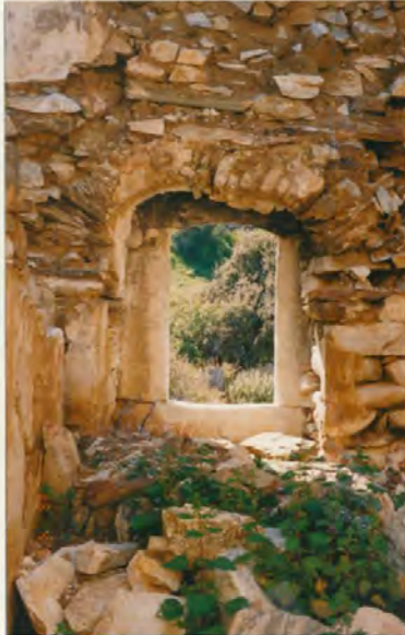
εσωτερική όψη Ν.Α. τοίχου πηγή: αρχείο Τ. Κάρτα
