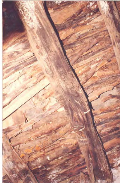
εικ.53 Ο φέρων οργανισμός των πατωμάτων όπως ήταν πριν την πυρκαγιά. πηγή: αρχείο Στέλλας Δεμενοπούλου
