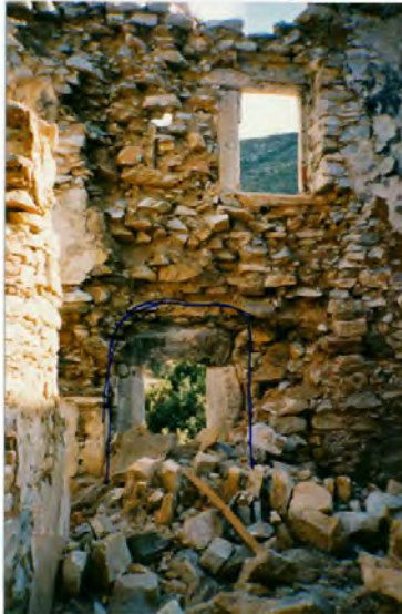
εσωτερική όψη Ν.Α. τοίχου
