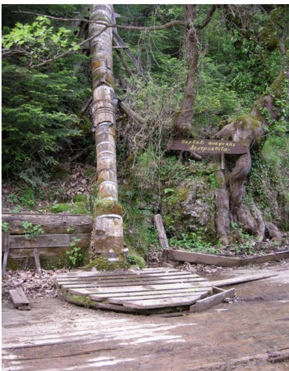
εικ. 19 Νεροτριβή, πάρκο υδροκίνησης Παύλιανης
