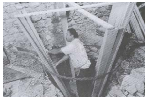
εικ. 21 Τοποθέτηση σφηνοειδών ταβλών στο τσέρκι-οδηγό κατά την κατασκευή της νεροτριβής
