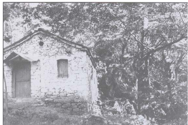
εικ. 9 Ο σταθμός ηλεκτροπαραγωγής στα Μαντάμια
