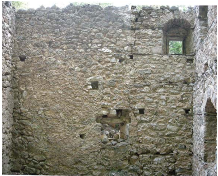
εικ. 32 αποψη δυτικού τοίχου από το εσωτερικό
