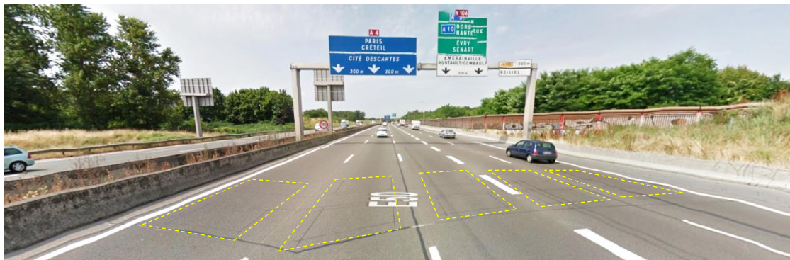
Figure 2 - Capteurs à deux boucles électromagnétiques de la section 4 de l'autoroute A4, dans le sens 2, sur une zone de sortie à deux voies en affectation (source : google maps, street view)
