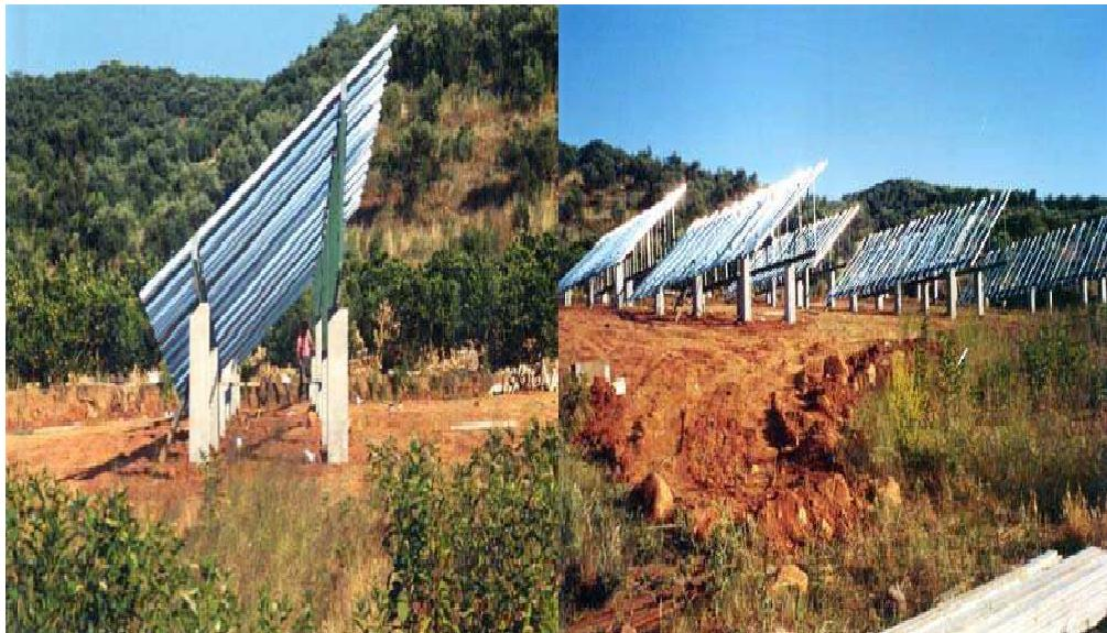
Σχήμα 2.1 Υποδομή στήριξης φωτοβολταϊκών κυψελών
