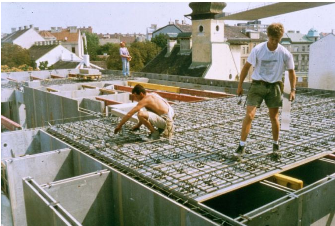
Εικ .21. Κατασκευή πατώματος από μοριόπλακες συγκολλημένες με τσιμέντο (Eltomation, Holland).
