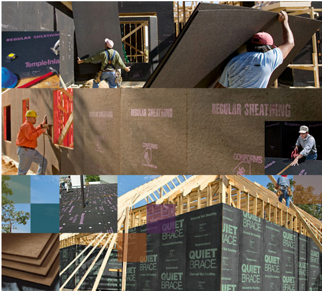
Εικ. 28. Χρήση ινοπλακών στην κατασκευή ξύλινων τοίχων. (Temple-Inland, USA)
