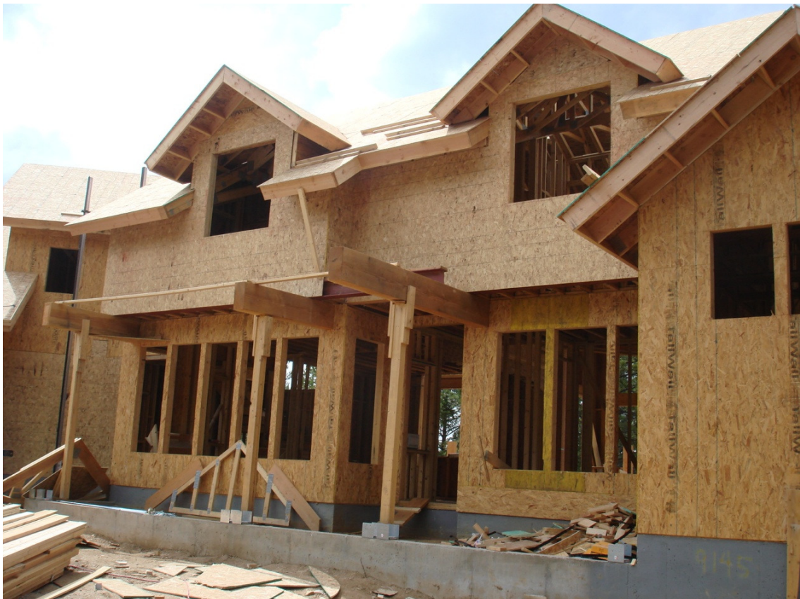
Εικ 17. Κατοικία με φέροντα οργανισμό από ξύλο (τοιχους, πάτωμα, στέγη) και ξυλόπλακες από OSB. (EVstudio)
