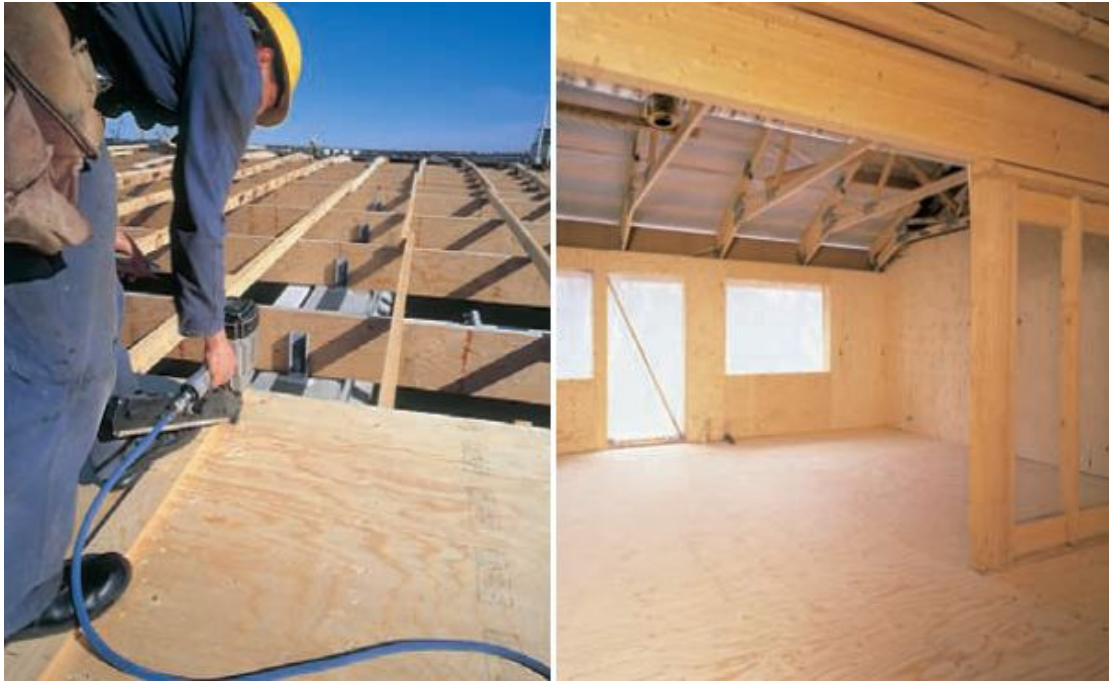
Εικ. 6. Χρήση της Αντικολλητής ξυλείας σε στέγες (Αριστερά) και πατώματα (Δεξιά) ( www.finnforest.com )
