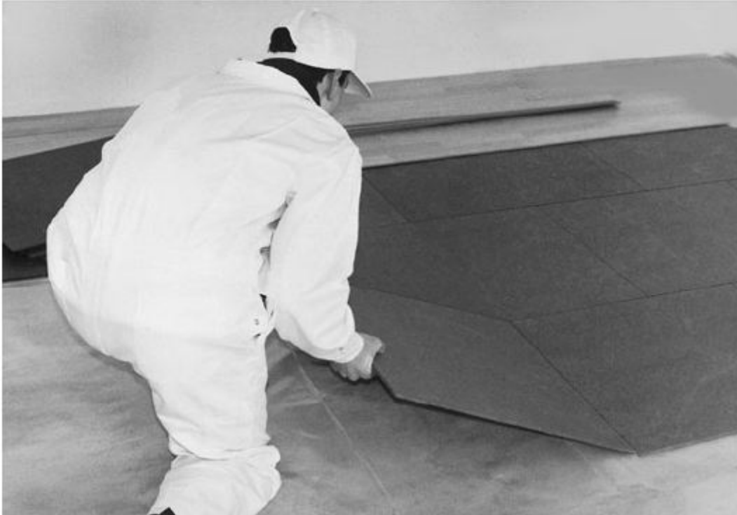
Εικ. 30. Χρήση των μαλακών ινοπλακών στην κατασκευή υποστρώματος για για ξύλινο δάπεδο. (Panel Agency Limited, UK)
