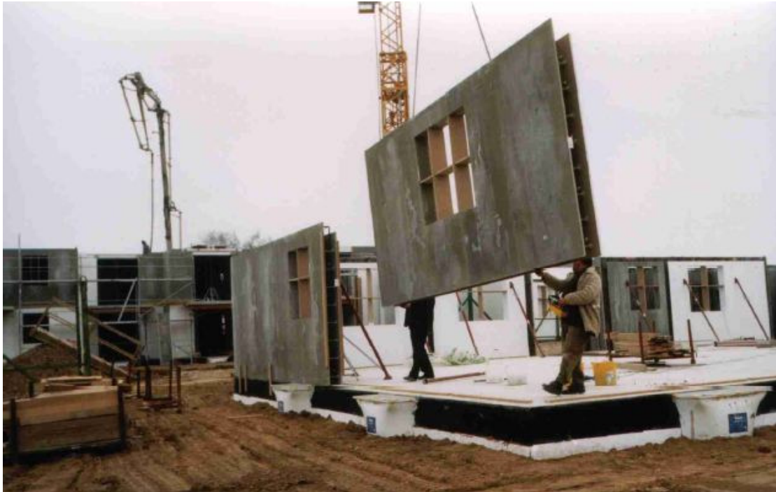
Εικ .20. Κατασκευή τείχων από μοριόπλακες συγκολλημένες με τσιμέντο(Eltomation, Holland).
