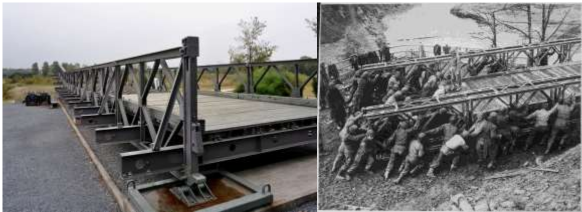
Εικόνα 2: Ένα τμήμα γέφυρας Bailey στο μουσείο Memorial Πήγασος στη Γαλλία (αριστερά). Συμμαχικά στρατεύματα κατά την καθέλκυση γέφυρας Bailey (δεξιά).
