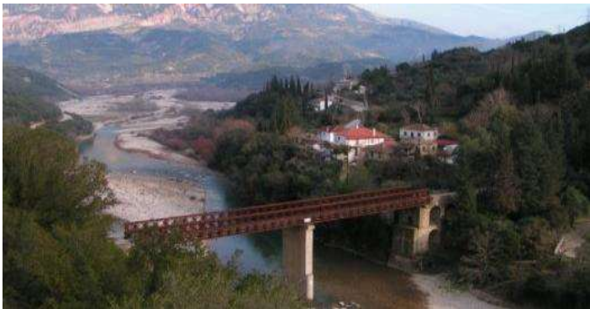
Εικόνα 4: Η γέφυρα του Θέρμου
