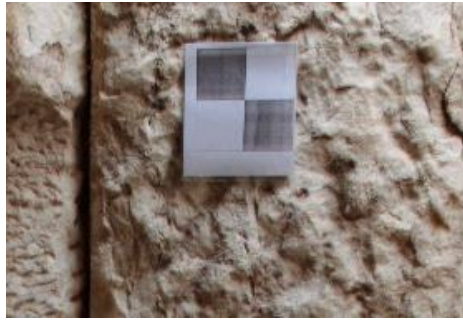
Εικόνα 3.2.1: Φωτοσταθερό σημείο στο εσωτερικό τμήμα του μνημείου
