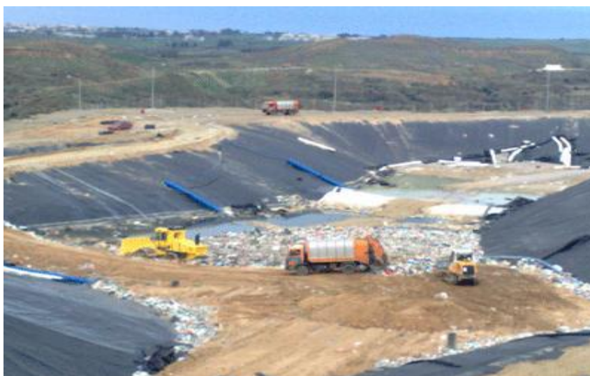
Εικόνα 2: Χώρος υγειονομικής ταφής στερεών αποβλήτων (Χ.Υ.Τ.Α.)
