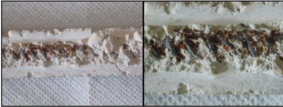
ΕΙΚ 5.15 ΔΟΚΙΜΙΟ [9] ΚΑΤΑ ΤΗΝ ΑΠΟΣΚΥΡΟΔΕΤΗΣΗ
