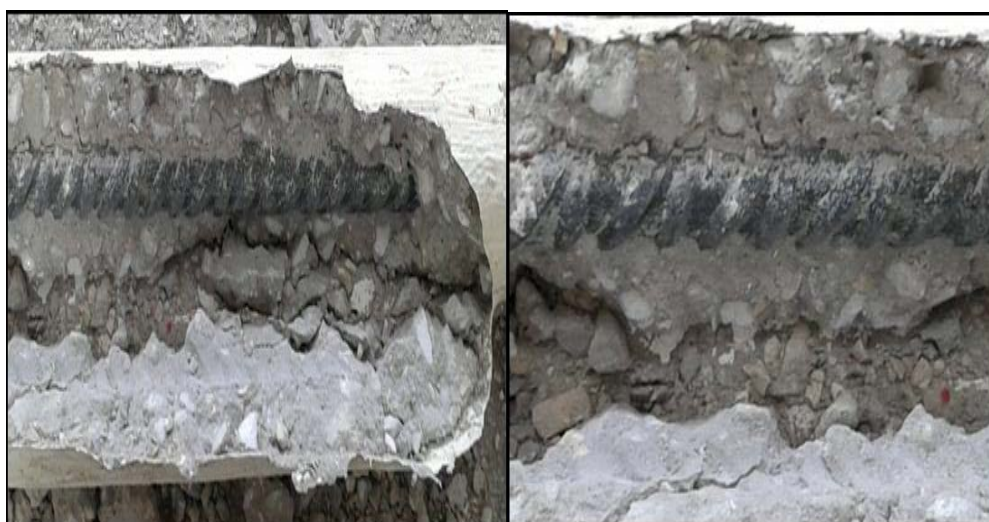
ΕΙΚ 5.14 ΔΟΚΙΜΙΟ [1] ΚΑΤΑ ΤΗΝ ΑΠΟΣΚΥΡΟΔΕΤΗΣΗ
