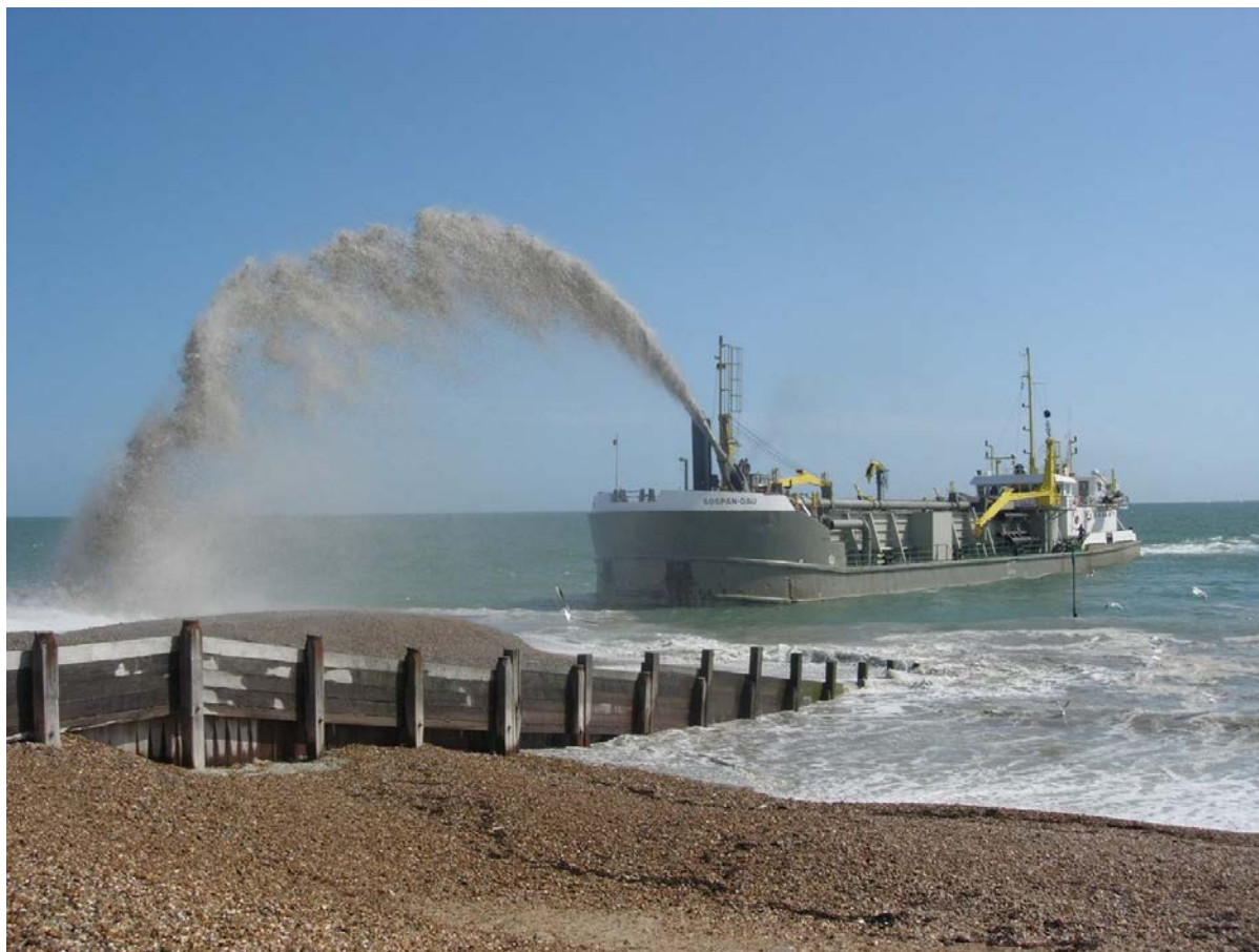
Εικόνα 3.6 Βυθοκόρος σε διαδικασία απόρριψης ιζήματος για αναπλήρωση ακτής ( www.escp.org.uk )
