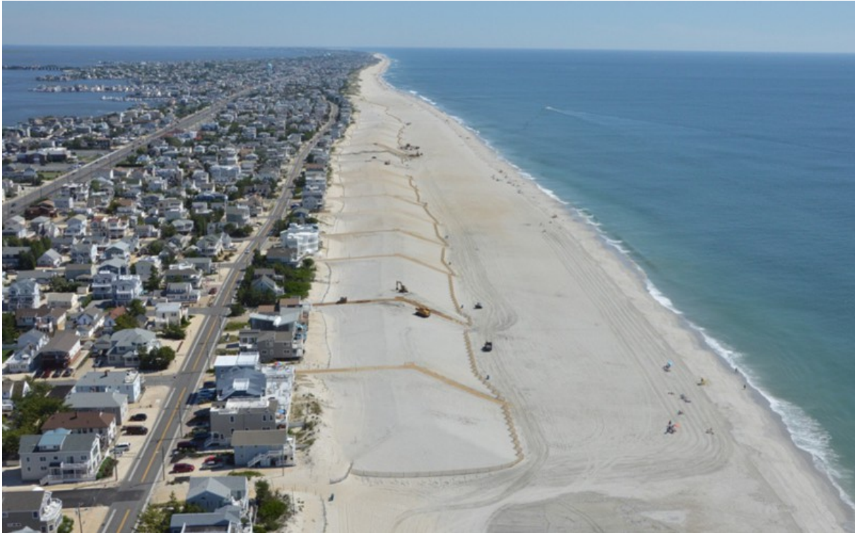
Εικόνα 3.5 Πρόγραμμα εκτεταμένης αναπλήρωσης ακτής στο Atlantic City των ΗΠΑ ( www.gldd.com )
