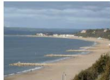
Εικόνα 3.1 Έργα προστασίας ακτής κατά σειρά: κυματοθραύστες, θωράκιση με ογκόλιθους και πρόβολοι (www.panoramio.com)
