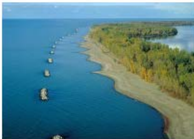
Εικόνα 3.1 Έργα προστασίας ακτής κατά σειρά: κυματοθραύστες, θωράκιση με ογκόλιθους και πρόβολοι (www.panoramio.com)
