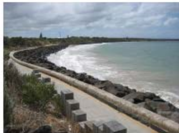
Εικόνα 3.1 Έργα προστασίας ακτής κατά σειρά: κυματοθραύστες, θωράκιση με ογκόλιθους και πρόβολοι (www.panoramio.com)
