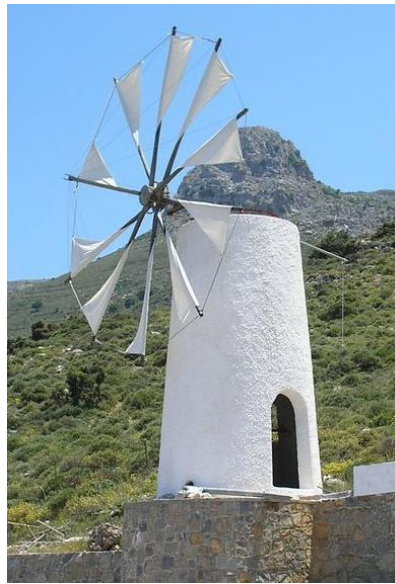
Εικόνα 2.15: Αντλητικός ανεμόμυλος στο οροπέδιο Λασιθίου (Πηγή: Wikipedia)
