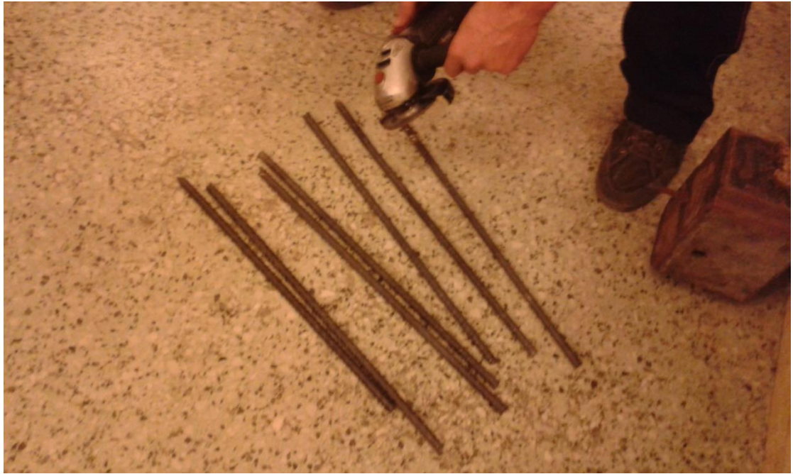
5.7 Κοπή των ράβδων με τροχό
