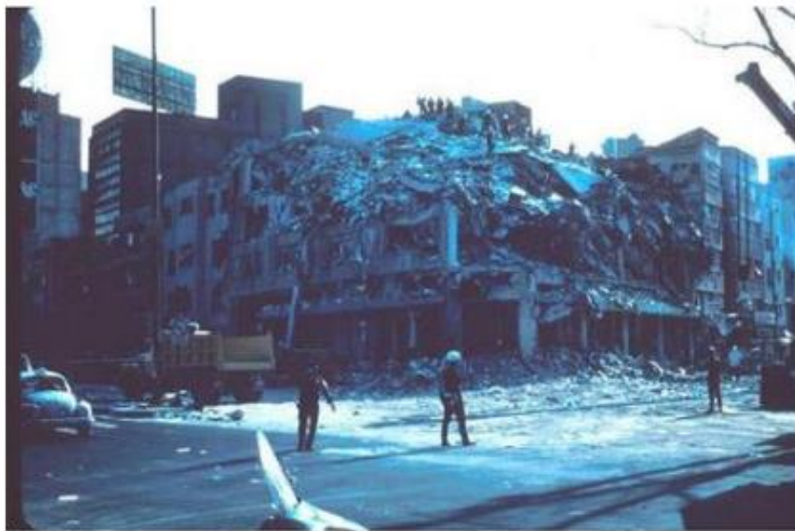
Σχήμα 1.3- Μεξικό 1985-δυσμενέστερη περίπτωση κρούσης λόγω σεισμού όμορων κτιρίων, κατάρρευση 8 όροφου κτιρίου
