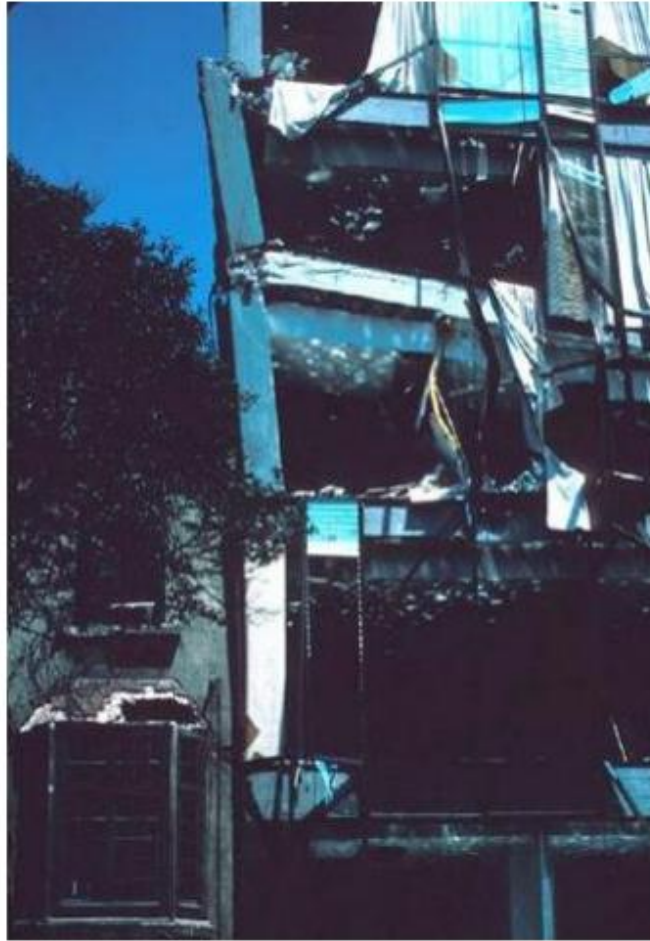
Σχήμα 1.3- Μεξικό 1985-δυσμενέστερη περίπτωση κρούσης λόγω σεισμού όμορων κτιρίων, κατάρρευση 8 όροφου κτιρίου
