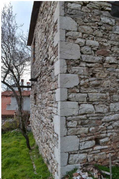
Εικόνα 6 Ημιλαξευτή λιθοδομή με λαξευμένους γωνιόλιθους
