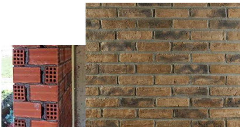
Εικόνα 13 Σωστή κατά το πάχος και σε όψη τοποθέτηση αντίστοιχα
