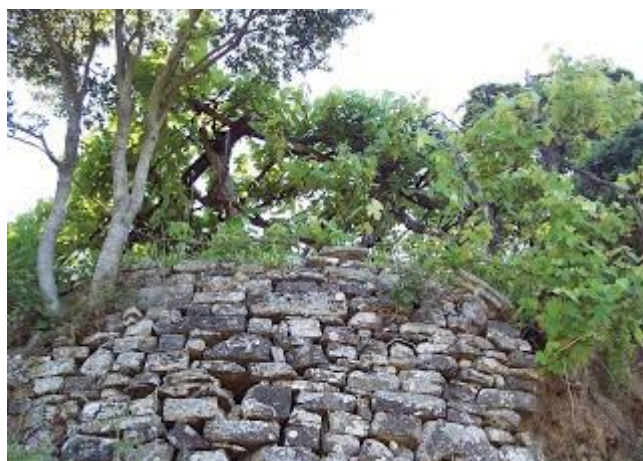
Εικόνα 4 Ξηρολιθοδομή
