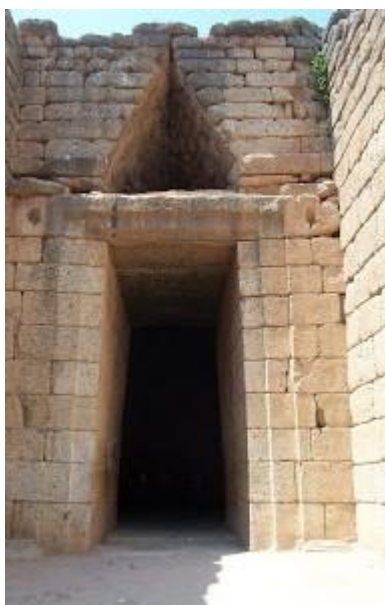
Εικόνα 7 Λαξευτή λιθοδομή
