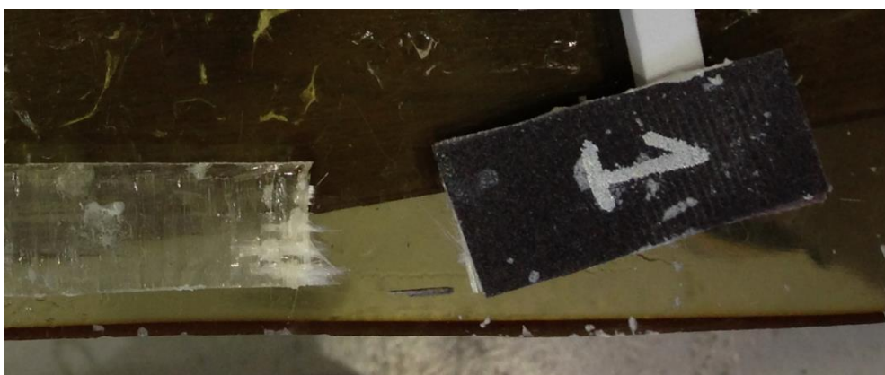
Σχήμα 3.51: Δοκίμιο TT1 μετά την αστοχία
