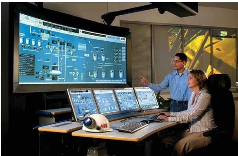
Σχήμα 2. 5 Κεντρικός σταθμός Scada
