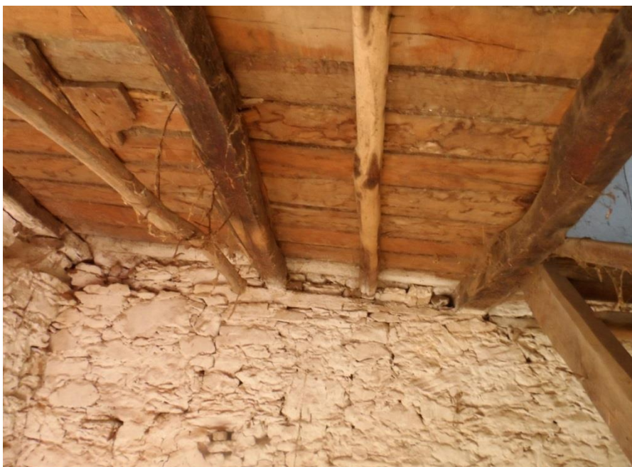
Σχ. 2.6.1 Εμφανές το πάτωμα και τα δοκάρια του πρώτου ορόφου λόγω απουσίας ταβανιού στο ισόγειο της δυτικής μεριάς
