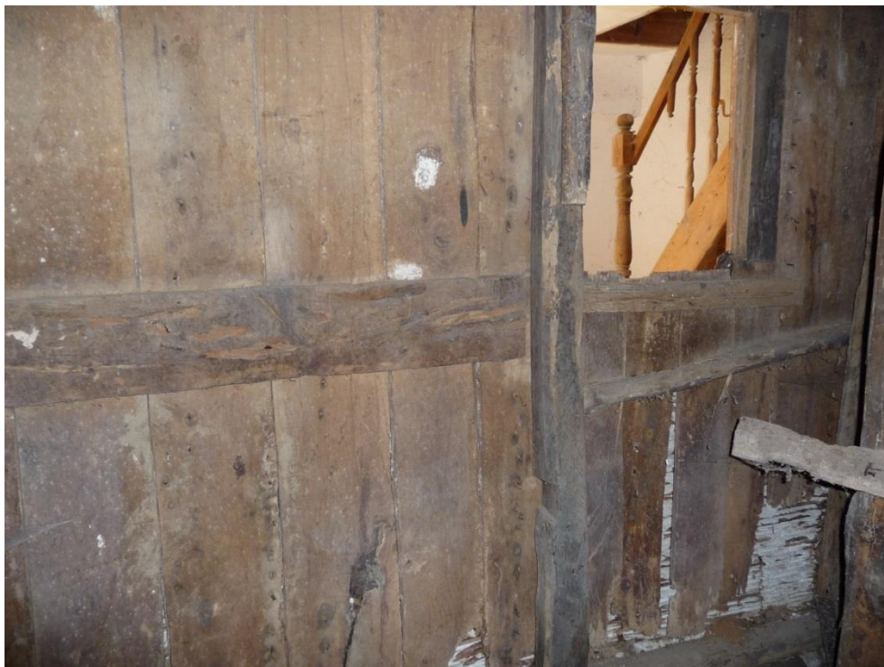
Σχ. 2.5.4 Εσωτερικός διαχωριστικός τοίχος στο ισόγειο της ανατολικής μεριάς
