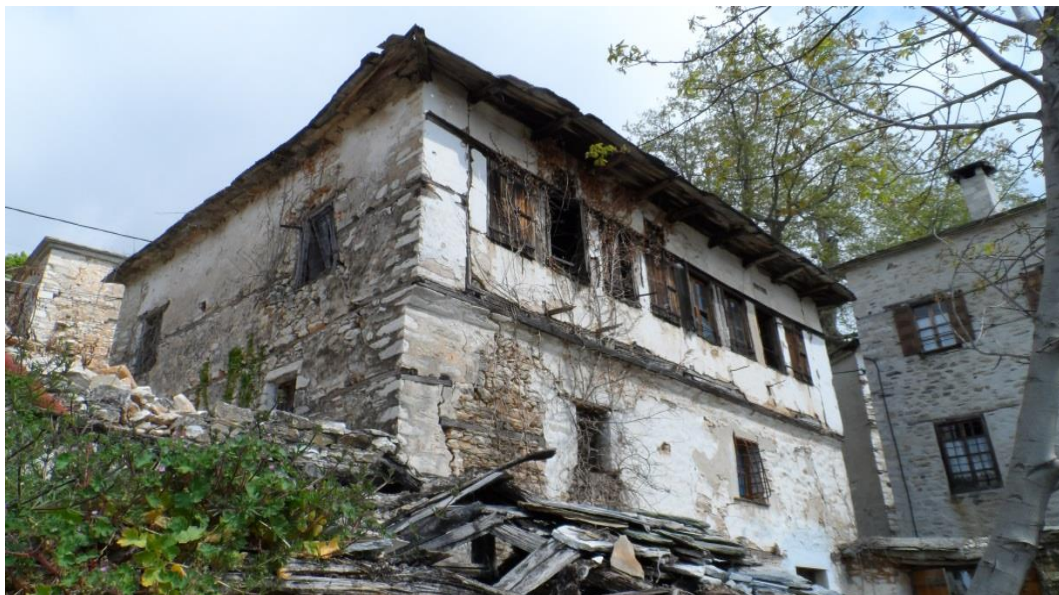
Σχ. 2.2.1 Γενική φωτογραφία του κτηρίου μελέτης (νοτιοδυτική οπτική)
