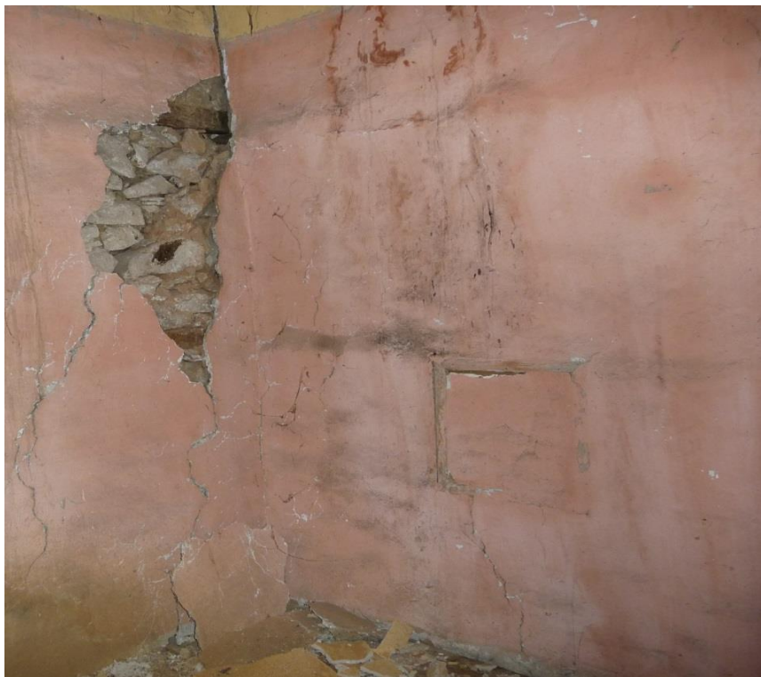
Σχ. 2.6.3 Εσωτερικοί τοίχοι ανατολικής μεριάς
