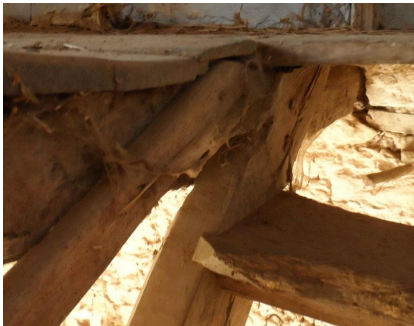
Σχ. 3.2.8 Φωτογραφία στήριξης σκάλας στις δοκούς του πατώματος
