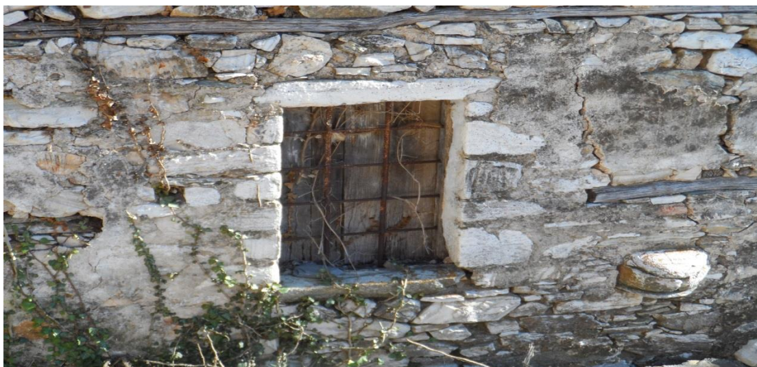
Σχ. 2.4.2 Πέτρινα πρέκια ανοιγμάτων
