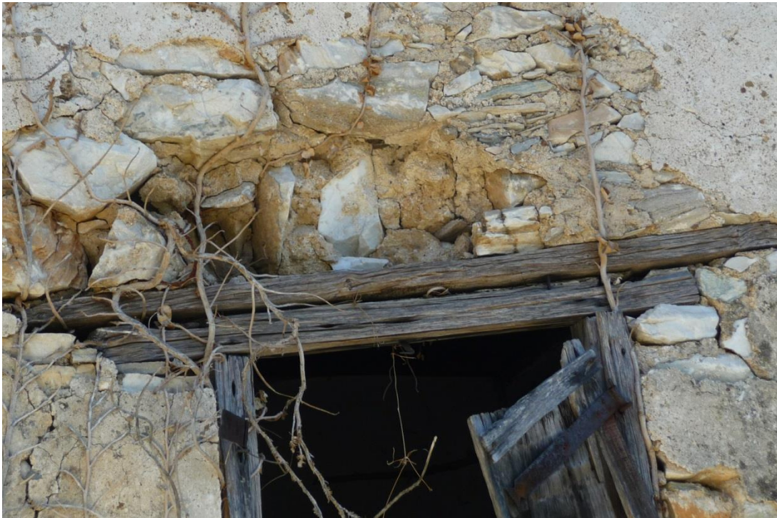
Σχ. 4.3.3 Τοπική κατάρρευση τοιχοποιίας σε υπέρθυρο παραθύρου της δυτικής όψης
