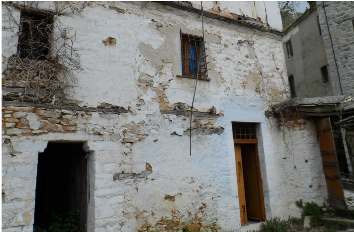
Σχ. 2.2.2 Επεμβάσεις με επίχρυσμα στην ανατολική και νότια όψη αντίστοιχα
