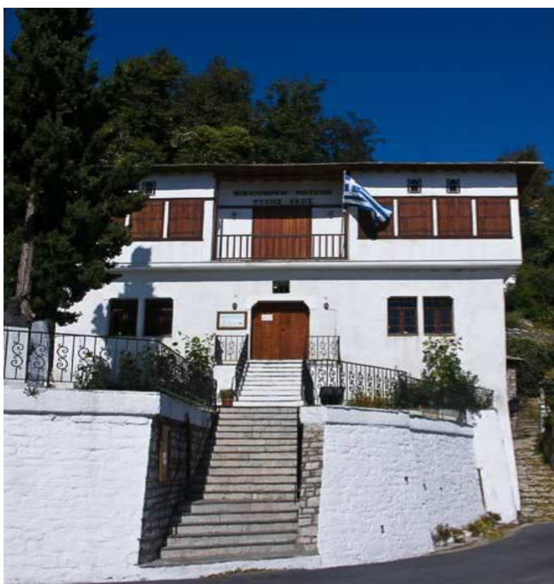
Σχ. 1.2.5 Κτίσμα της ύστερης πηλιορείτικης αρχιτεκτονικής
