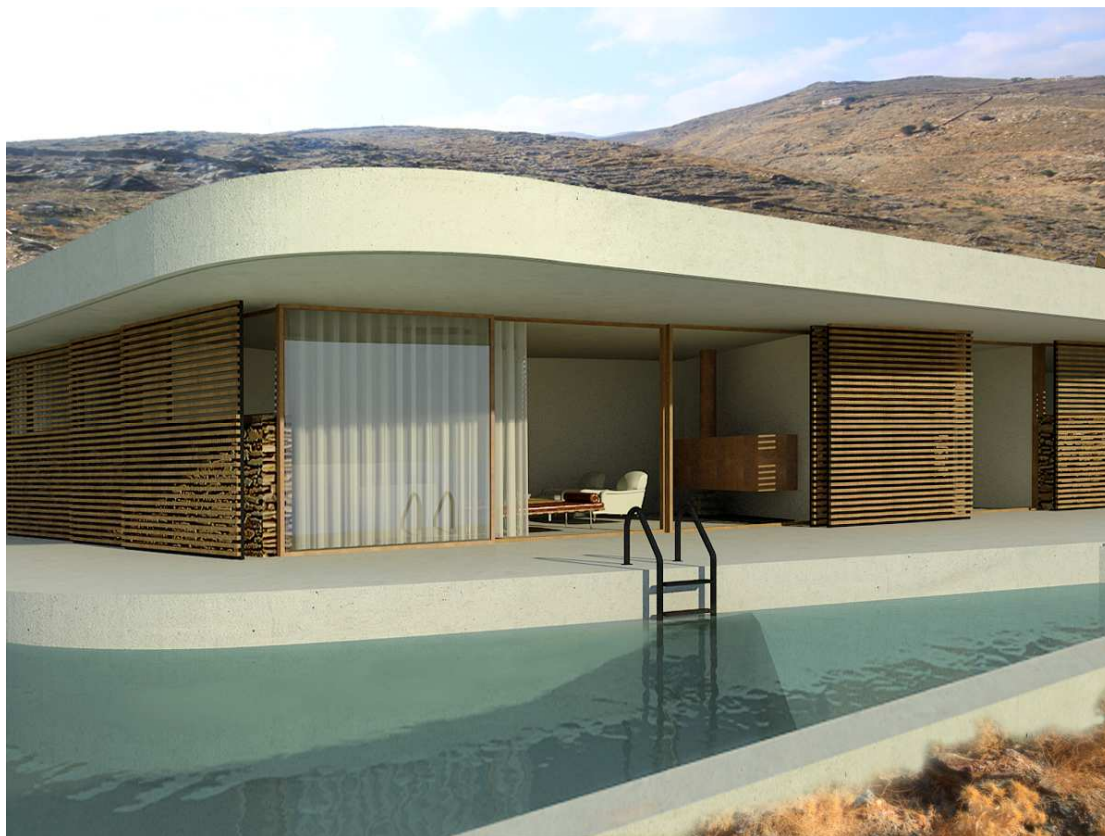
Εικόνα 7.6 Νότια όψη της υπόσκαφης κατασκευής
