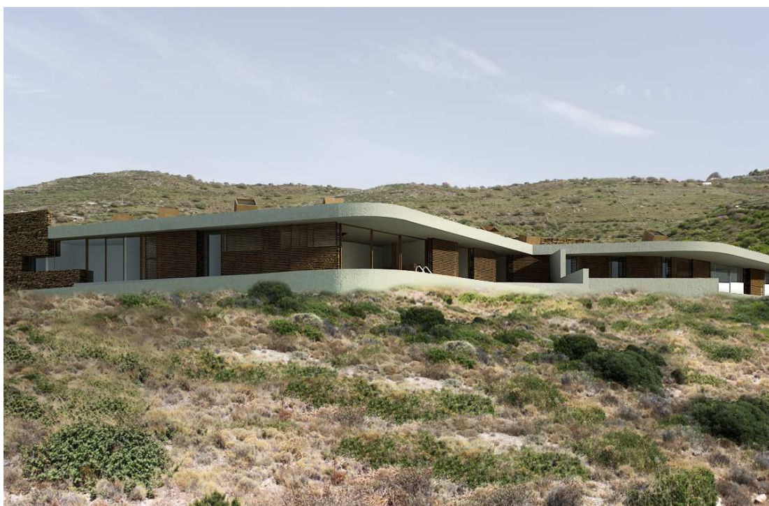
Εικόνα 7.1. Εξωτερική άποψη της υπόσκαφης κατασκευής.
