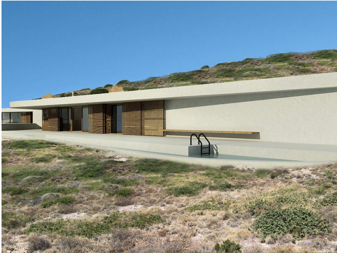
Εικόνα 7.5. Νότια όψη της υπόσκαφης κατασκευής.
