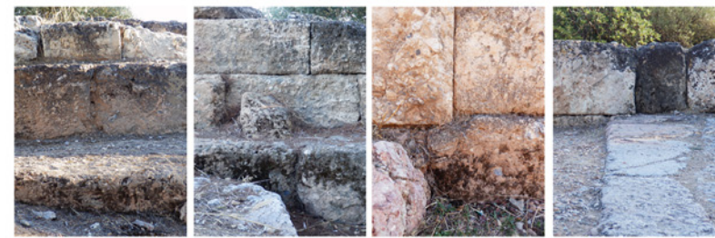
ΘΕΜΕΛΙΩΣΗ ΔΙΑΤΕΙΧΙΣΜΑΤΟΣ ΣΤΗΝ ΕΥΘΥΝΤΗΡΙΑ ΑΝΑΤΟΛΙΚΗΣ ΣΤΟΑΣ
