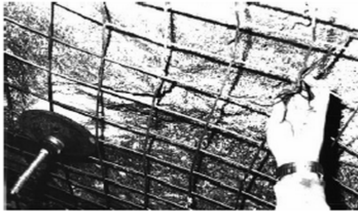
Εικόνα 3.35 τοποθέτηση πλέγματος ενίσχυσης εκτοξευόμενου σκυροδέματος
